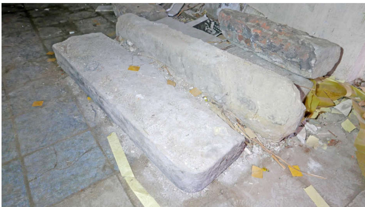
Fot. nr 68. Kraków, Plac Kossaka 4, parter, pom. nr LU.1.2, widoczne zdemonstrowane piaskowcowe stopnie schodów zewnętrznych (nr el. zab IV – 2) Fot. M.J.Łukacz 2020 r.
