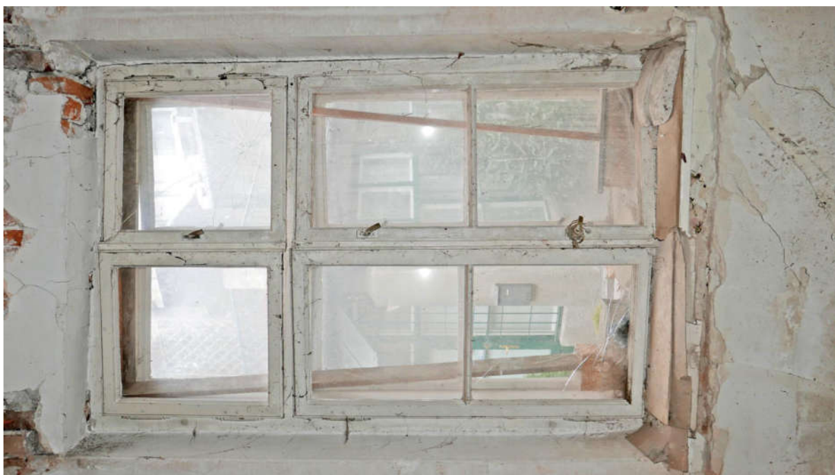
Fot. nr 28. Kraków, Plac Kossaka 4, parter, pom. nr 1.2, widoczna stolarka okna o konstrukcji skrzynkowej, czteroskrzydłowej, sześciopolewej, z zachowanymi zawiasami typu francuskiego oraz klameczkami (nr el. zab. I – O2) Fot. M.J.Łukacz 2020 r.
