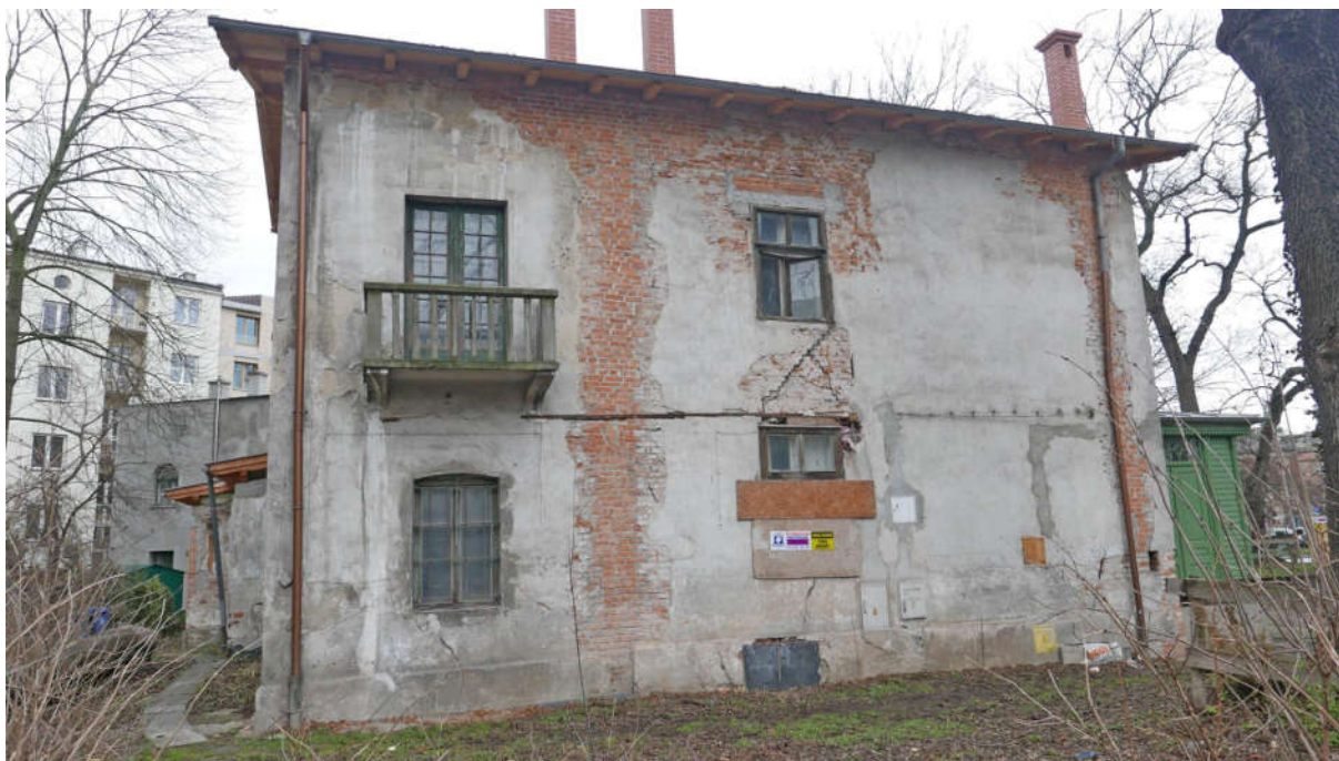
Fot. nr 3. Kraków, Plac Kossaka 4, elewacja zachodnia pozbawiona wystroju architektonicznego, dołem obwiedziona gładkim cokołem, widok ogólny, stan obecny; górą widoczny balkon o konstrukcji żelbetowej w poziomie poddasza użytkowego (nr el. zab. IV-1), stolarka okien skrzynkowych sześć- i cztero polowych (nr el. zab. I-O3, I-O5) a także stolarka drzwi balkonowych (nr el. zab. I-OB) Fot. M.J.Łukacz 2020 r.
