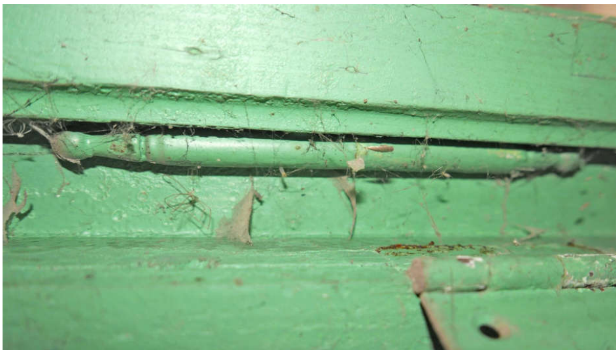
Fot. nr 33. Kraków, Plac Kossaka 4, parter, pom. nr LU.1.1, widoczny zawias typu francuskiego stolarka okna o konstrukcji skrzynkowej, czteroskrzydłowej, czteropolowej, z zachowanymi mosiężnymi klameczkami (nr el. zab. I-O3) Fot. M.J.Łukacz 2020 r.
