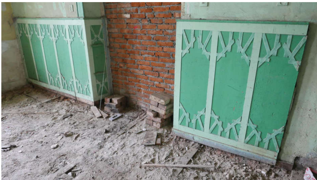
Fot. nr 66. Kraków, Plac Kossaka 4, parter, pom. nr LU.1.1, widoczne zachowane fragmenty boazerii o konstrukcji ramowo-płycinowej, z płycinami ozdobionymi w narożnikach skrzyżowanymi listwami (nr el. zab. I – Bo2) Fot. M.J.Łukacz 2020 r.
