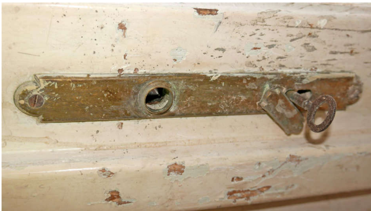
Fot. nr 41. Kraków, Plac Kossaka 4, poddasze, pom. nr 2.9, widoczny mosiężny szyld stolarki drzwiowej prowadzącej na balkon (nr el. zab. I-OB) Fot. M.J.Łukacz 2020 r.
