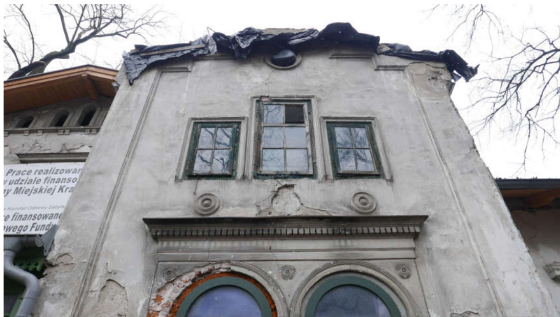
Fot. nr 7. Kraków, Plac Kossaka 4 , elewacja południowa, fragment, widoczny wystrój architektoniczny sekcji środkowej elewacji w postaci profilowanych obramień otworów okiennych parteru z fryzem kostkowym oraz medalionami o prostej dekoracji w formie kwiatów i tondami powyżej poziomu gzymsu okiennego. Schodkowa w formie profilowana opaska ramuje w poziomie poddasza profilowaną opaskę okulusa ( nr el. zab. V - 1 ), górą widoczna stolarka trzech okien ( nr el. zab. I-O7 ) Brak środkowego tonda, por. il. nr XXVII. Fot. M.J.Łukacz 2020 r.
