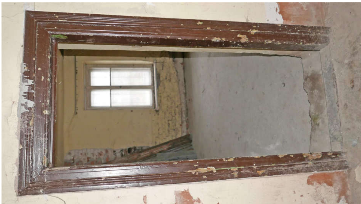
Fot. nr 25. Kraków, Plac Kossaka 4, parter, pom. nr 2.7, widoczne profilowane obramienie ościeżnicy stolarki drzwiowej jednoskrzydłowej (o zdemontowanym skrzydle drzwi) (nr el. zab. I – Do) Fot. M.J.Łukacz 2020 r.
