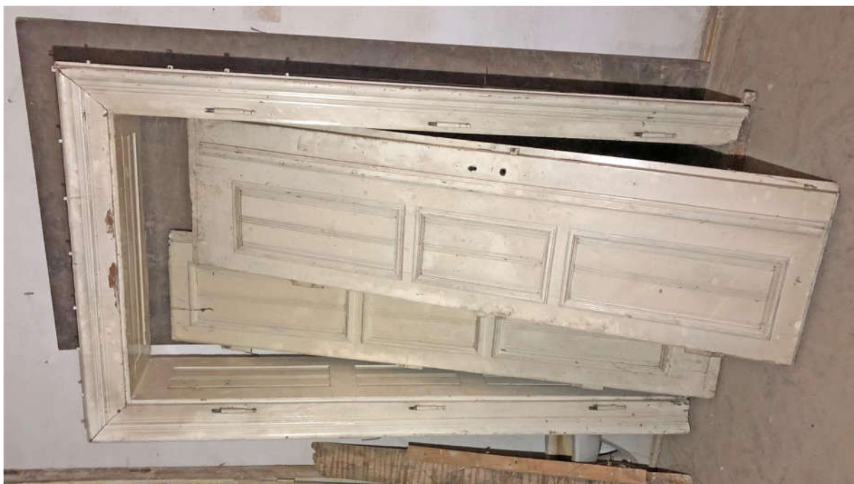
Fot. nr 61, 62. Kraków, Plac Kossaka 4, parter, pom. nr 2.1, widoczny zdemontowany zestaw stolarki drzwiowej, dwuskrzydłowej o konstrukcji płycinowej, sześciopolowej wraz z trójpółową płycinową ościeżnicą z profilowanym obramieniem (o podziale pól nawiązującym do układu profili podziałów drewnianej boazerii, por. fot, nr 52) z zachowanymi zawiasami typu francuskiego (nr el. zab. I – D5) Fot. M.J.Łukacz 2020 r.
