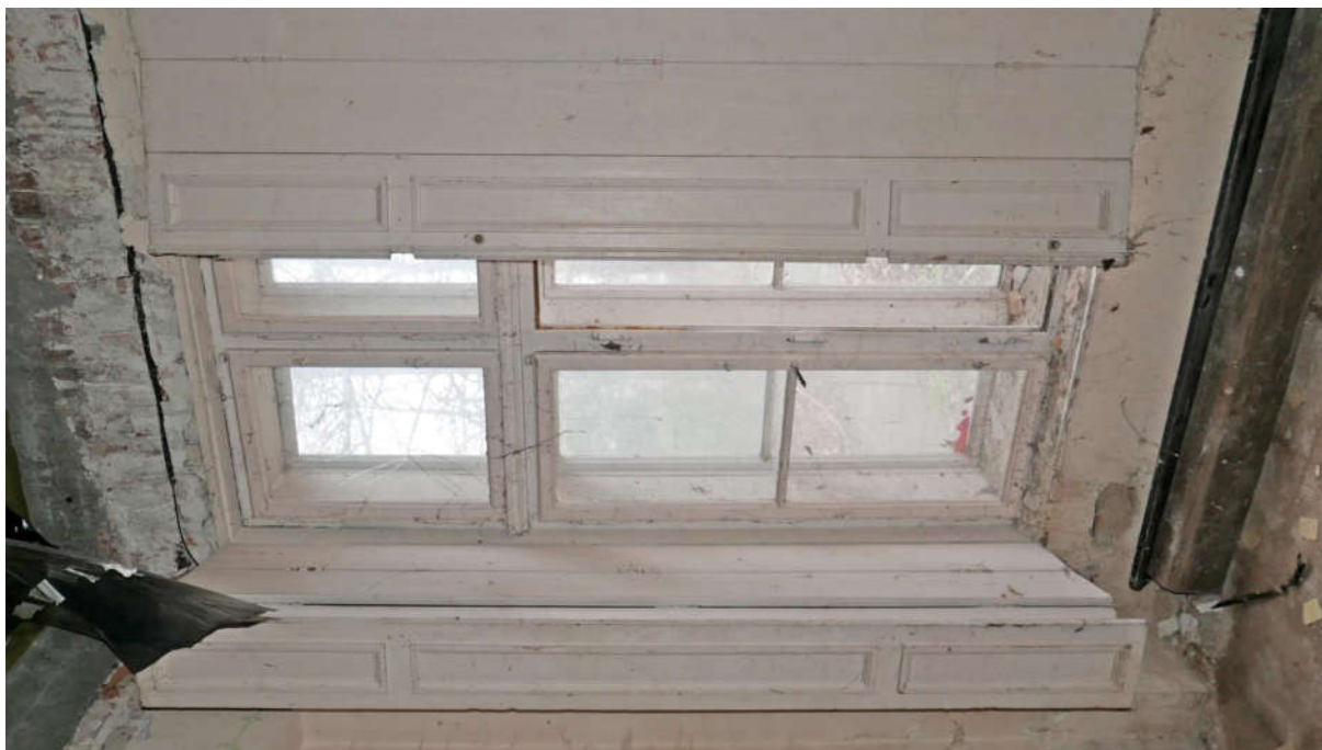
Fot. nr 35, 36. Kraków, Plac Kossaka 4, parter, pom. nr LU.1.2, widoczne detale stolarki okna o konstrukcji skrzynkowej, sześcioskrzydłowej, dziewięciopolowej z profilowanymi, trójpolowymi, składanymi szpaletami, z zachowanymi zawiasami typu francuskiego oraz klamczkami i szplintami skrzydeł (nr el. zab. I-O4) Fot. M.J.Łukacz 2020 r.
