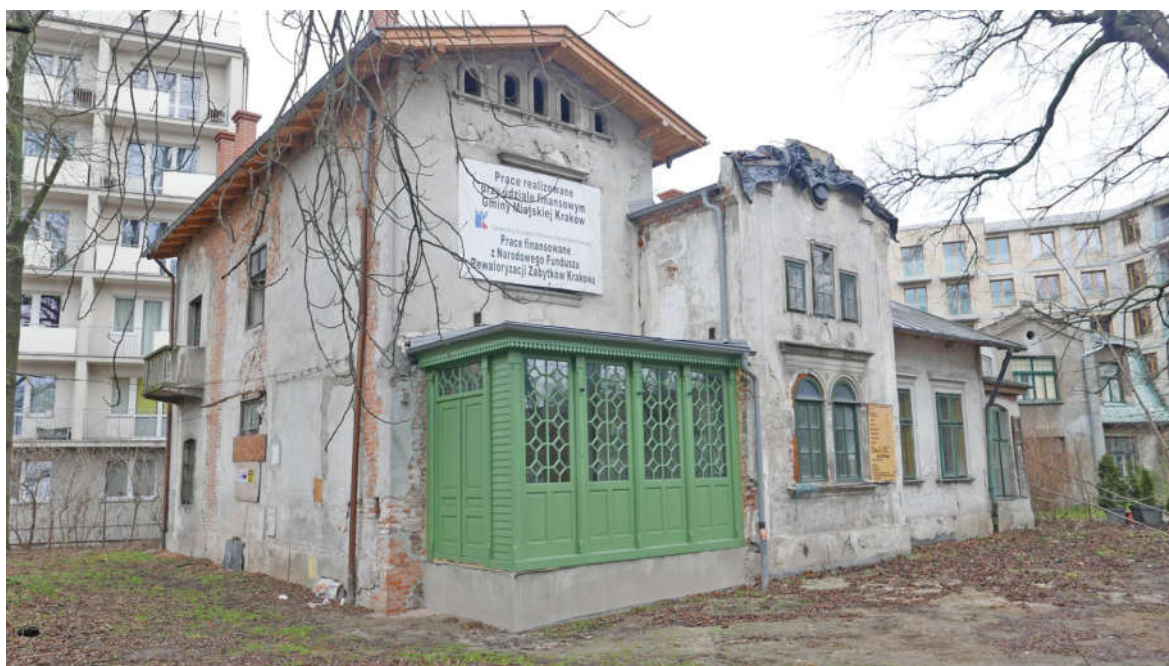
Fot. nr 1, 2. Kraków, Plac Kossaka 4, elewacja południowa, widok ogólny, stan obecny; widoczna stolarka okienna (nr el. zab. I-O3, I-O4, I-O7) oraz wystrój architektoniczny elewacji w postaci profilowanych obramień otworów okiennych - w partii wschodniej w postaci płaskich gzymsów okiennych oraz profilowanych parapetów, zaś w części środkowej ponad otworami zamkniętymi półkoliście, wzbogaconych dodatkowo fryzem kostkowym oraz medalionami o prostej dekoracji w formie kwiatów i tondami powyżej poziomu gzymsu okiennego. Sekcja środkowa elewacji obwiedziona jest schodkową w formie profilowaną opaską, zaś okna poddasza sekcji zachodniej spoczywają na wspólnym profilowanym parapecie, wspartym na skromnych w formie prostokątnych kroksztynach, górą w osi fasady widnieje profilowana opaska okulusa (nr el. zab. V - 1), dołem widok od strony elewacji zachodniej. Fot. M.J.Łukacz 2020 r.
