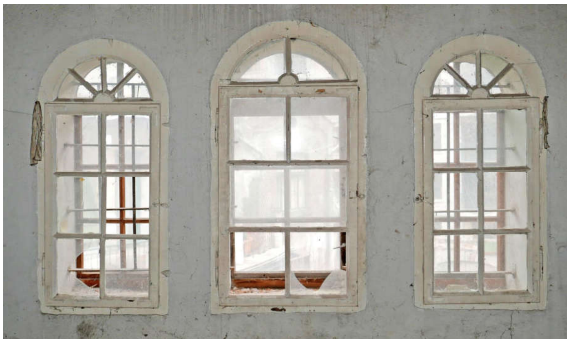
Fot. nr 45. Kraków, Plac Kossaka 4, poddasze, pom. nr 1.8, widoczny układ trzech jedno-skrzydłowych, zestawów stolarki elewacji wschodniej, zamkniętych półkolistymi nadpro-żami, wypełnionymi nieuchylnymi sekcjami o koncentrycznym podziale dwu- i cztero polowego szklenia oraz o skrzydłach sześciopolewych z zachowanymi zawiasami typu francuskiego. Od strony zewnętrznej skrzydła wymienione wtórnie (nr el. zab. I-O8) Fot. M.J.Łukacz 2020 r.
