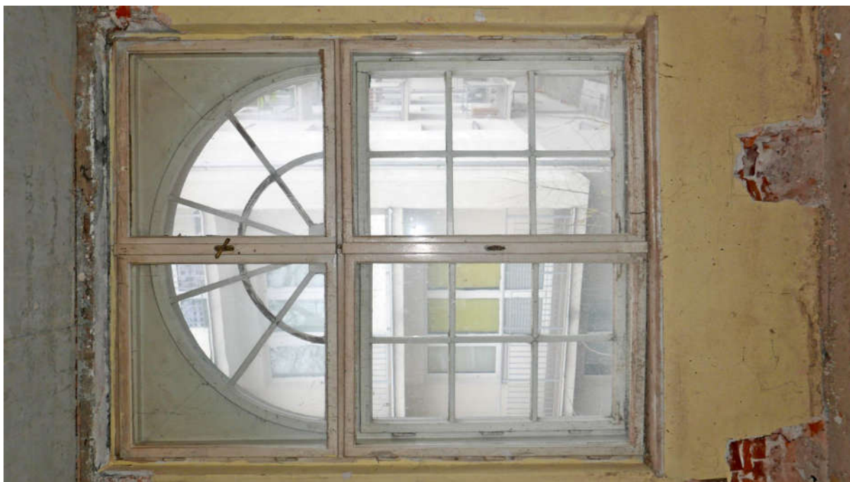
Fot. nr 39. Kraków, Plac Kossaka 4, poddasze, pom. nr 2.9, widoczna stolarka okna o konstrukcji skrzynkowej, od strona wnętrza w układzie czteroskrzydłowym, czteropolowym, zaś od zewnątrz o półkolistej formie nadproża, dzielonej w górnej sekcji koncentrycznie szczelinami 10-cio polowo oraz o dolnych skrzydłach sześciopolowych ( nr el. zab. I-O6 ) Fot. M.J.Łukacz 2020 r.
