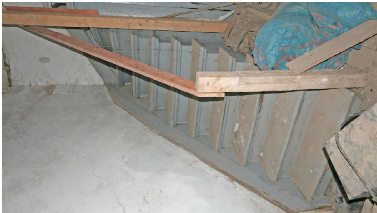
Fot. nr 49, 50. Kraków, Plac Kossaka 4, parter, pom. nr W0.4, widoczny zabiegowy bieg schodów prowadzący na poddasze o konstrukcji drewnianej z profilowanymi podniesieniami stopni oraz z niezachowaną obecnie balustradą (nr el. zab. I - S) por. fot. 51. Fot. M.J.Łukacz 2020 r.
