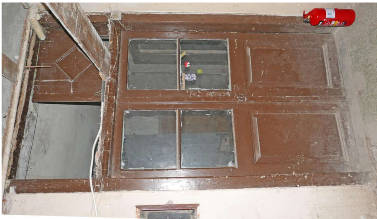
Fot. nr 19, 20. Kraków, Plac Kossaka 4, parter, pom. nr W0.1, widoczna stolarka drzwi płycinowych, dwuskrzydłowych czteropolowych, z górnymi polami przeszklonymi, dzielonymi dodatkowo szczeliną oraz z dwuskrzydłowym przeszklonym nadświetłem (wtórnie zamalowanym o podziale szczelinami zbieżnym ze stolarką werandy ) o zachowanym skrzydle dzielonym prostą w formie dekoracją geometryczną rombu oraz z zawiasami typu francuskiego; poniżej widoczny zachowany stylowy szyld (nr el. zab. I - D2) Fot. M.J.Łukacz 2020 r.
