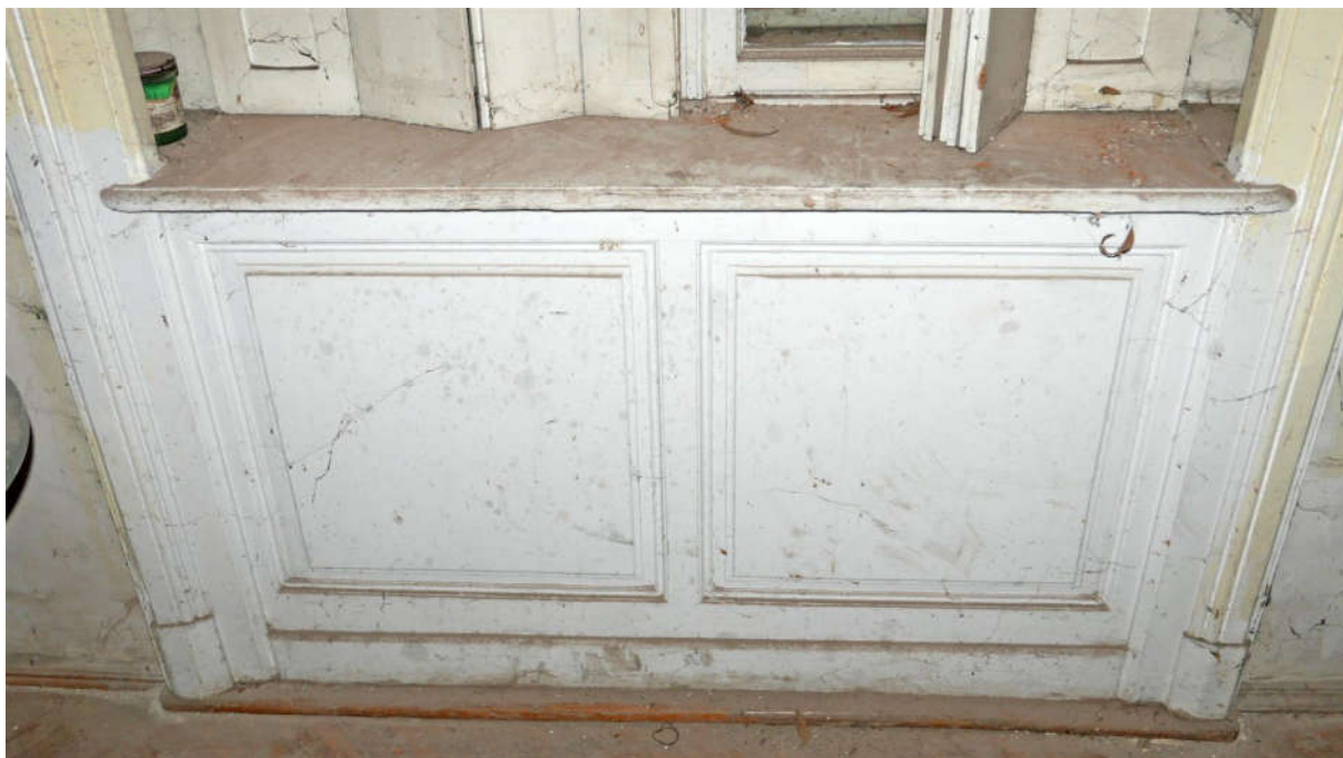
Fot. nr 37, 38. Kraków, Plac Kossaka 4, parter, pom. nr 2.1, widoczna stolarka okna o konstrukcji skrzynkowej, czteroskrzydłowej, czteropolowej z profilowanymi, trójpółowymi, składanymi szpaletami, z zachowanymi zawiasami typu francuskiego oraz klameczkami i szplintami skrzydeł a także z obramieniem sięgającym poziomu parkietu wraz z profilowanym, płycinowym, dwupółowym wypełnieniem partii podparapetowej (nr el. zab. I-O5) Fot. M.J.Łukacz 2020 r.
