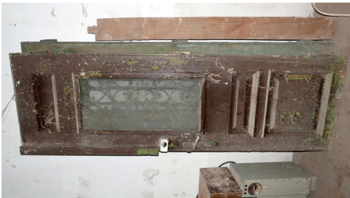
Fot. nr 59, 60. Kraków, Plac Kossaka 4, parter, pom. nr 2.1, widoczny zdemontowany zestaw dwuskrzydłowej stolarki drzwiowej (prowadzącej do budynku) o konstrukcji płycinowej, ośmiopolowej, zwieńczonej tympanonami o najdłuższym polu przeszklonym z kratami kwater wykonanymi z profili fabrycznych o symetrycznej dekoracji geometrycznej oraz zachowanymi zawiasami typu francuskiego oraz z sztyldami i klamkami (nr el. zab. I – D1) por il. nr XXVIII. Fot. M.J.Łukacz 2020 r.
