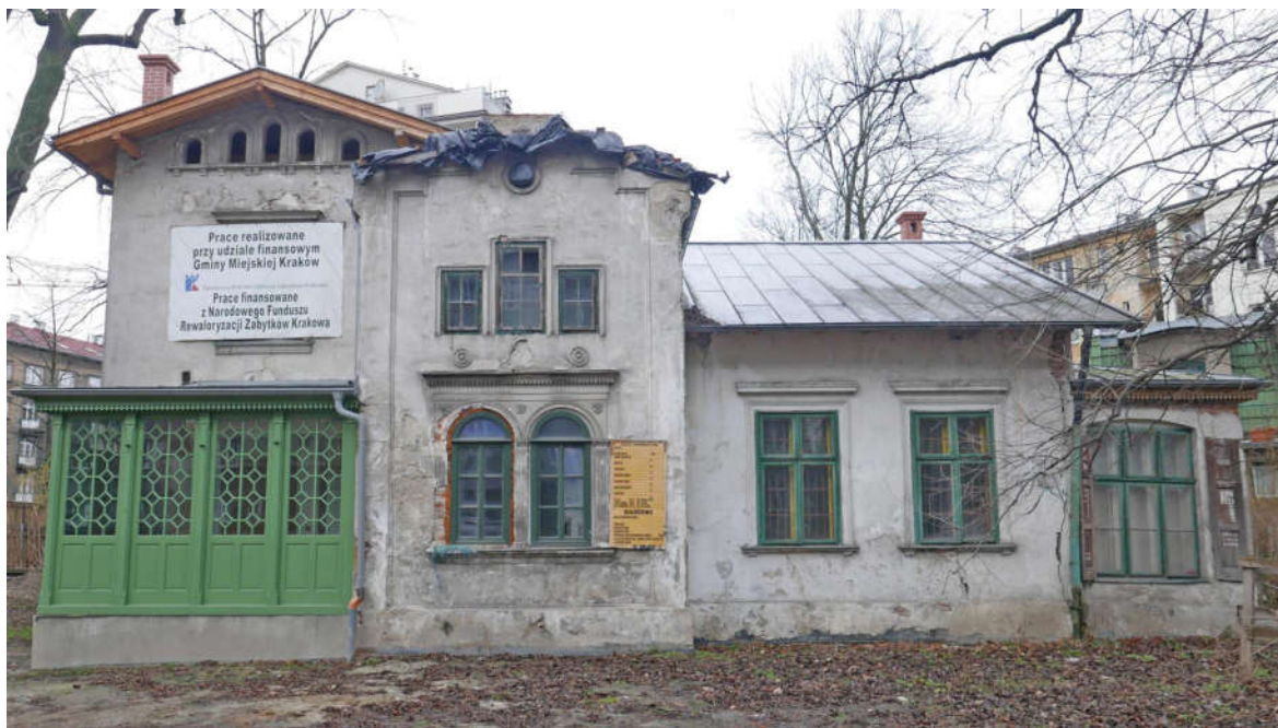
Fot. nr 1, 2. Kraków, Plac Kossaka 4, elewacja południowa, widok ogólny, stan obecny; widoczna stolarka okienna (nr el. zab. I-O3, I-O4, I-O7) oraz wystrój architektoniczny elewacji w postaci profilowanych obramień otworów okiennych - w partii wschodniej w postaci płaskich gzymsów okiennych oraz profilowanych parapetów, zaś w części środkowej ponad otworami zamkniętymi półkoliście, wzbogaconych dodatkowo fryzem kostkowym oraz medalionami o prostej dekoracji w formie kwiatów i tondami powyżej poziomu gzymsu okiennego. Sekcja środkowa elewacji obwiedziona jest schodkową w formie profilowaną opaską, zaś okna poddasza sekcji zachodniej spoczywają na wspólnym profilowanym parapecie, wspartym na skromnych w formie prostokątnych kroksztynach, górą w osi fasady widnieje profilowana opaska okulusa (nr el. zab. V - 1), dołem widok od strony elewacji zachodniej. Fot. M.J.Łukacz 2020 r.
