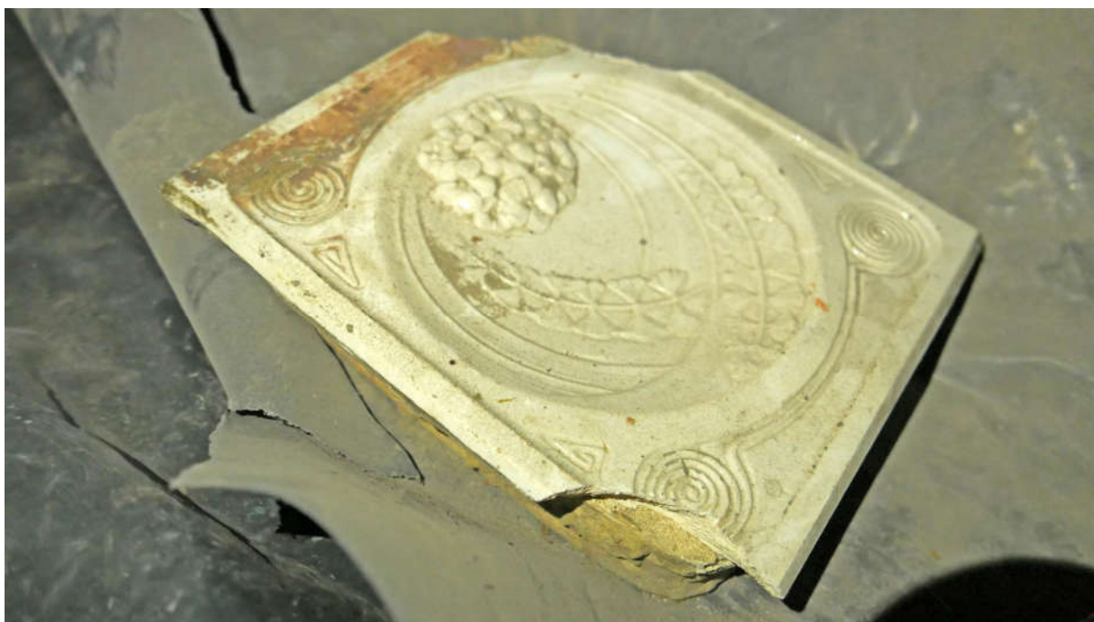
Fot. nr 55, 56. Kraków, Plac Kossaka 4, parter, pom. nr 2.2, widoczne luźno złożone i niewłaściwie składowane kafle niefachowo rozebranych piecy. Rozmaitość form oraz kolorów kafli a także czytelne odmienne rodzaje ich dekoracji świadczą o pochodzeniu z co najmniej czterech pieców, należących do zabytkowego wyposażenia budynku (nr el. zab. II-1) Fot. M.J.Łukacz 2020 r.
