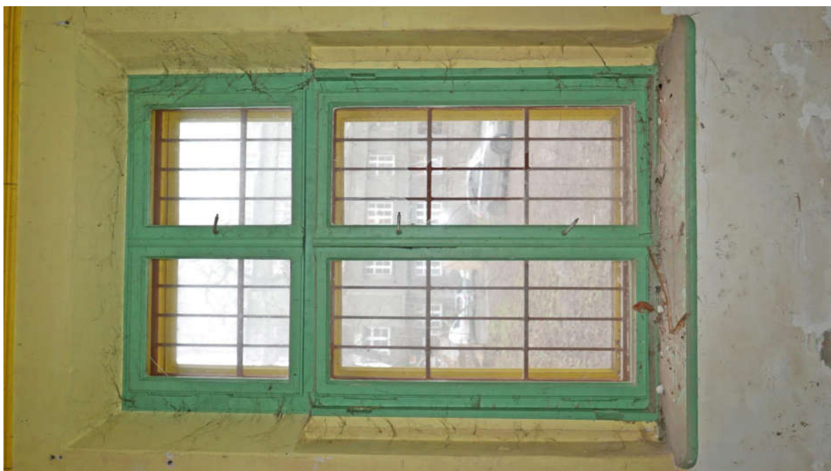
Fot. nr 31, 32. Kraków, Plac Kossaka 4, parter, pom. nr LU.1.1, widoczna stolarka okna o konstrukcji skrzynkowej, czteroskrzydłowej, czteropolowej z zachowanymi zawiasami typu francuskiego oraz mosiężnymi klameczkami. W ościeżach okna widoczne wnęki wykonane w tynku dla niezachowanych szpalet dolnych skrzydeł (nr el. zab. I-O3) Fot. M.J.Łukacz 2020 r.
