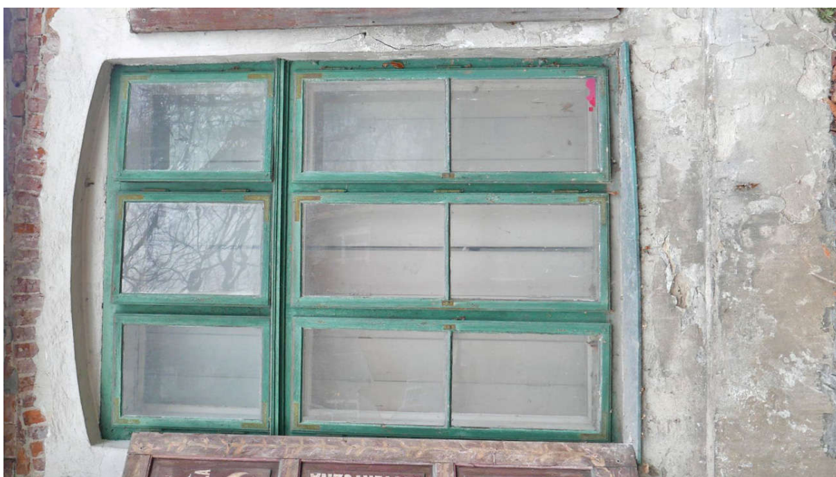
Fot. nr 34. Kraków, Plac Kossaka 4, elewacja południowa, widoczna stolarka okna o konstrukcji skrzynkowej, sześćskrzydłowej, dziewięciopolowej - o trzech dolnych skrzydłach dzielonych dwupolowo szczeblinami, z profilowanymi, trójpółowymi, składanymi szpaletami, z zachowanymi zawiasami typu francuskiego oraz klameczkami i szplintami skrzydeł (nr el. zab. I-O4) Fot. M.J.Łukacz 2020 r.
