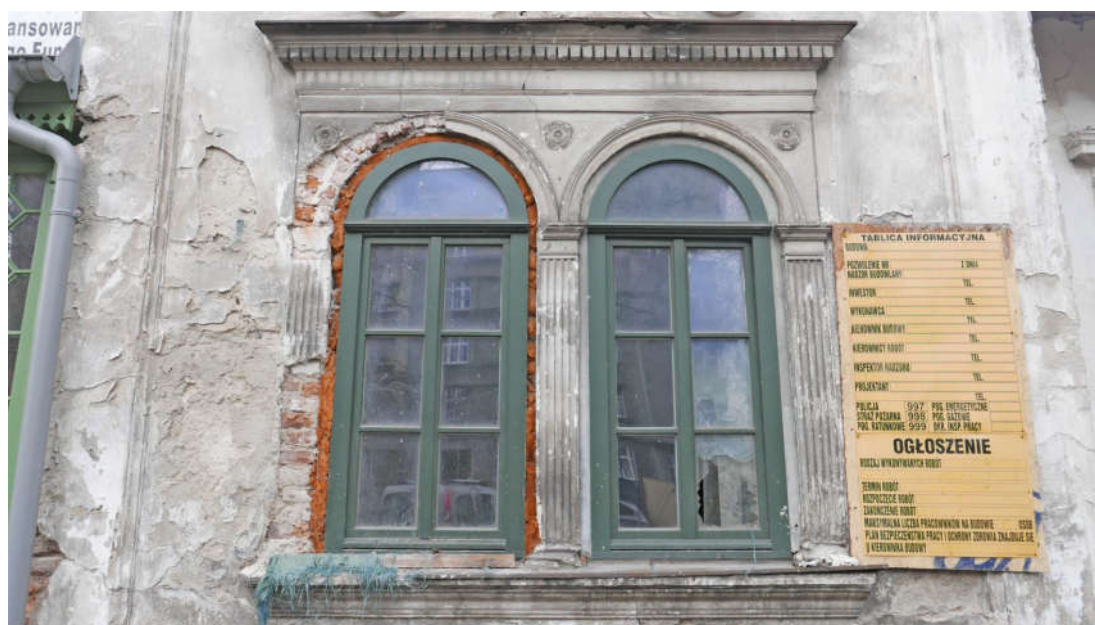
Fot. nr 6. Kraków, Plac Kossaka 4, elewacja południowa w poziomie parteru, fragment, widoczny wystrój architektoniczny sekcji środkowej elewacji w postaci profilowanych obramień otworów okiennych, spoczywających na kanelurowanych pilastrach, spoczywających na profilowanym parapecie o profilowanym gzymsie wieńczącym nadproża z fryzem kostkowym oraz medalionami o prostej dekoracji w formie kwiatów (nr el. zab. V - 1) Fot. M.J.Łukacz 2020 r.
