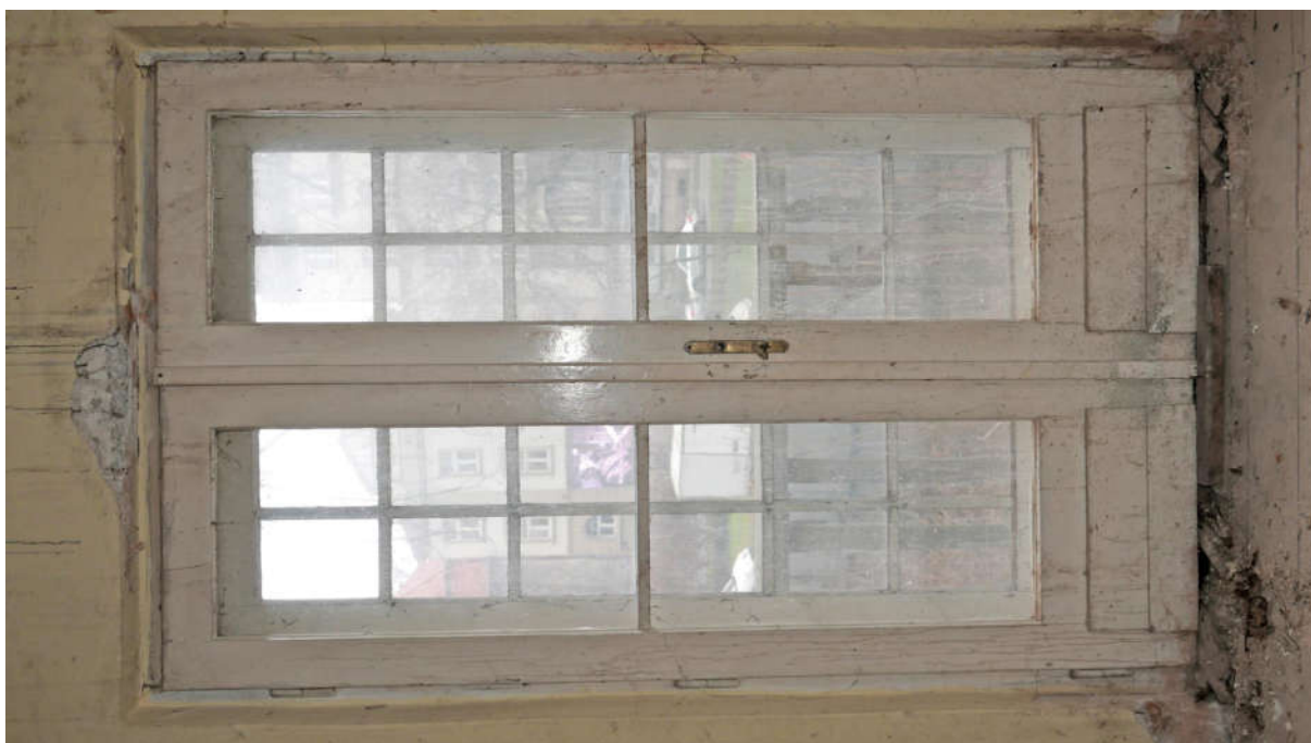
Fot. nr 40. Kraków, Plac Kossaka 4, poddasze, pom. nr 2.9, widoczna podwójna stolarka drzwiowa prowadząca na balkon, od wewnątrz czteropolowa o przeszkleniu dzielonym szczelinami z dolnymi sekcjami w postaci brudników, zaś od zewnątrz o wielopolowym podziale skrzydeł ( nr el. zab. I-OB ) Fot. M.J.Łukacz 2020 r.
