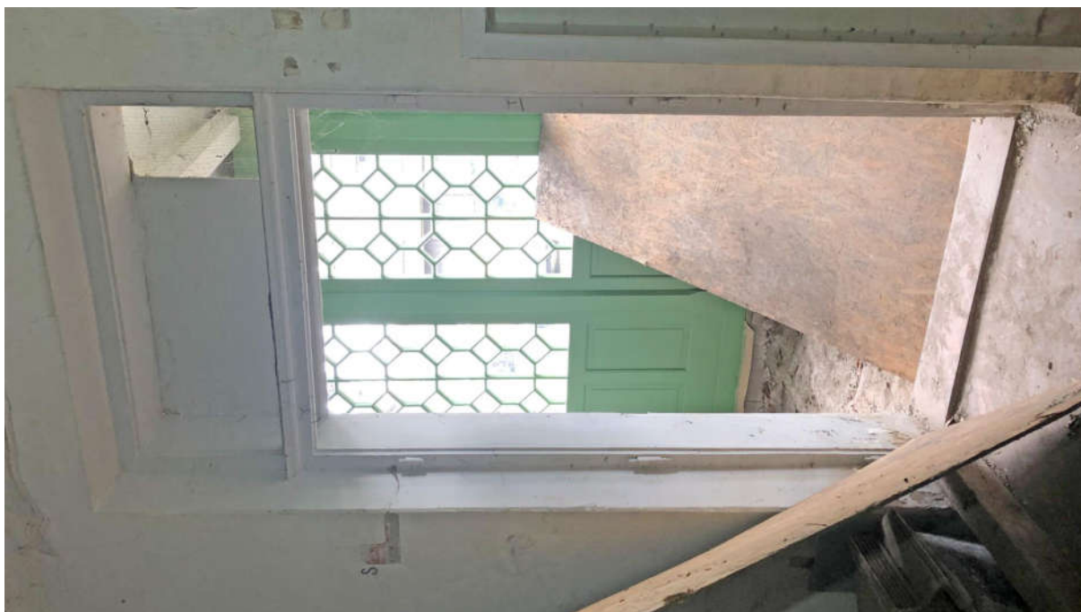
Fot. nr 71, 72. Kraków, Plac Kossaka 4, parter, pom. nr 2.1, widoczna zdemontowana stolarka drzwi dwuskrzydłowych, przeszklonych ośmiopolowych z wąskimi dolnymi płycinami o prostokątnym wypełnieniu, z nadświetłem ościeżnicy, prowadząca na werandę w elewacji południowej (nr el. zab I - D8) Fot. M.J.Łukacz 2020 r.
