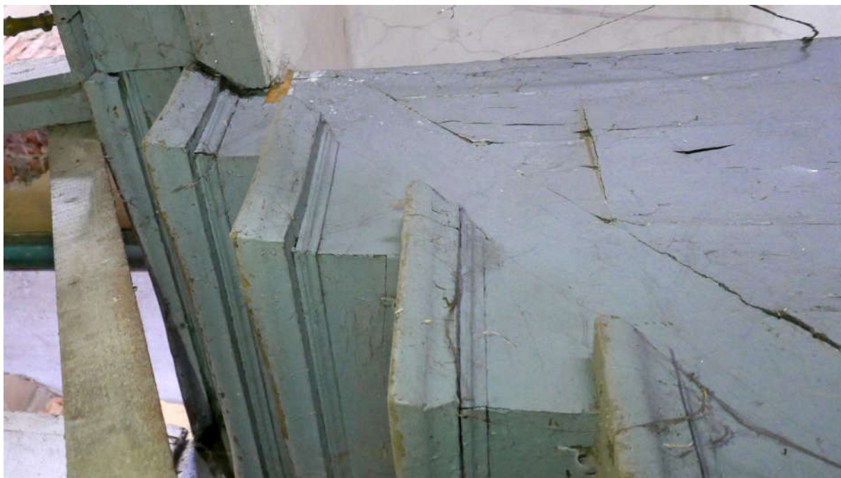
Fot. nr 49, 50. Kraków, Plac Kossaka 4, parter, pom. nr W0.4, widoczny zabiegowy bieg schodów prowadzący na poddasze o konstrukcji drewnianej z profilowanymi podniesieniami stopni oraz z niezachowaną obecnie balustradą (nr el. zab. I - S) por. fot. 51. Fot. M.J.Łukacz 2020 r.
