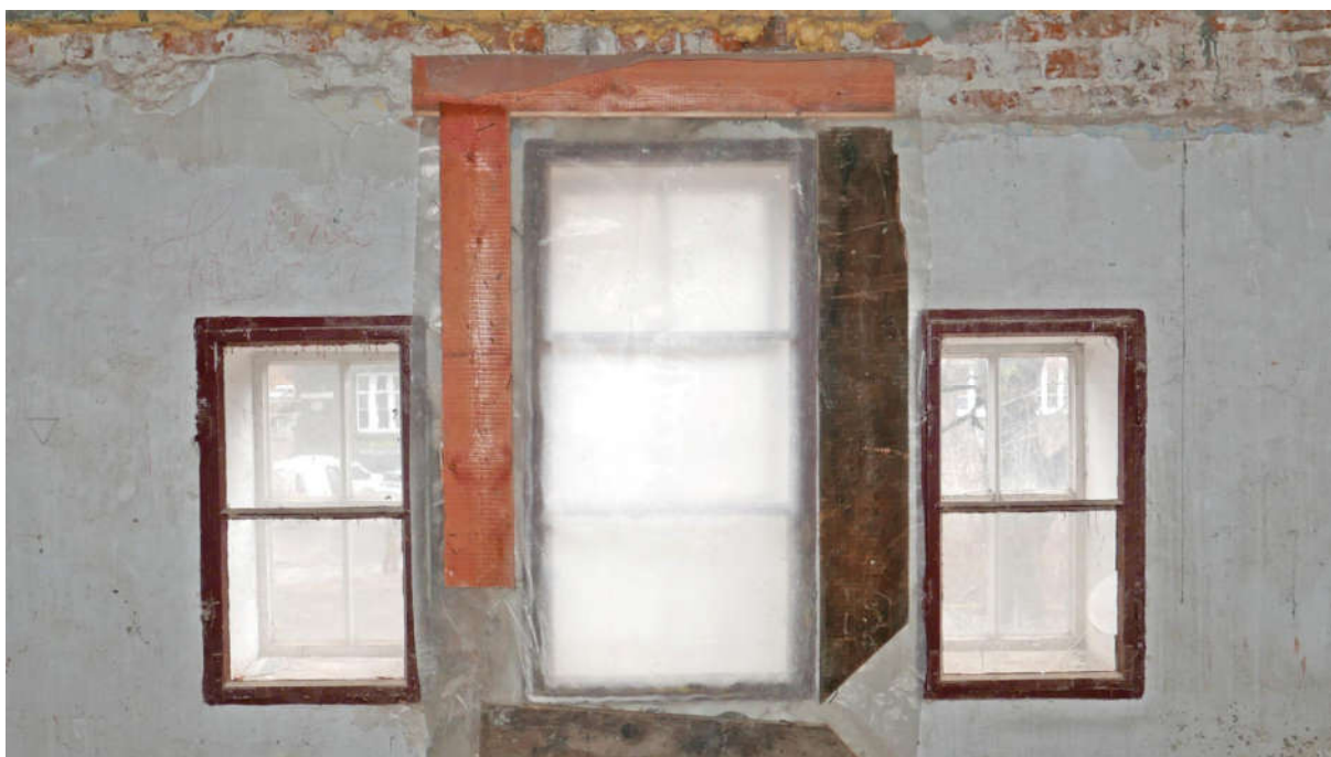
Fot. nr 44. Kraków, Plac Kossaka 4, poddasze, pom. nr 2.11, widoczny układ trzech jedno-skrzydłowych, prostych w formie zestawów stolarki tworzących kompozycję elewacji frontowej o skrajnych kwaterach dzielonych dwupolowo (czteropolowo od strony zewnętrznej) oraz o sześciopolowych skrzydłach okna środkowego (nr el. zab. I-O7) Fot. M.J.Łukacz 2020 r.
