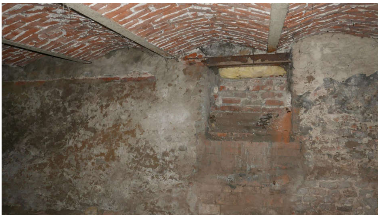
Fot. nr 75, 76. Kraków, Plac Kossaka 4, piwnice, widoczny stan obecny głównej komory piwnicznej, tynki ścian zasolone, zawilgocone oraz zagrzybione, górą ceramiczne sklepienie Klein'a. Fot. M.J.Łukacz 2020 r.
