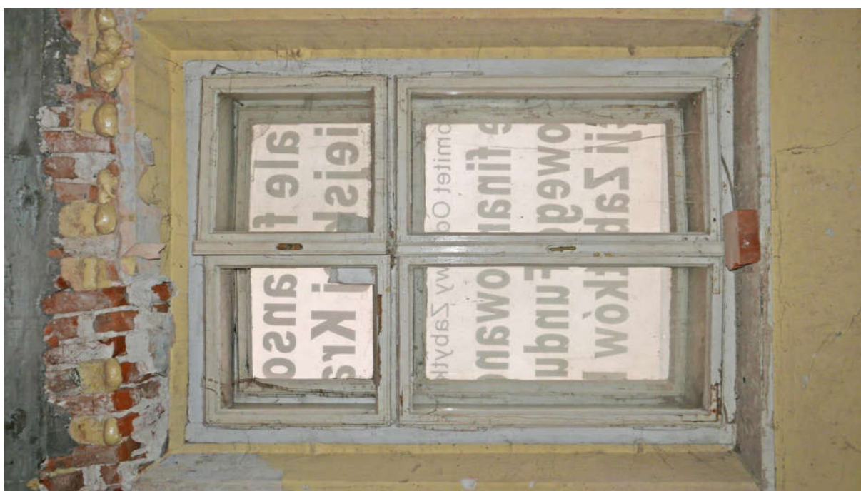
Fot. nr 42. Kraków, Plac Kossaka 4, poddasze, pom. nr 2.10, widoczna stolarka okna w typie (nr el. zab. I-O3) o konstrukcji skrzynkowej, czteroskrzydłowej, czteropolowej z zachowanymi zawiasami typu francuskiego oraz z częściowo zachowanymi mosiężnymi klameczkami oraz szyldzikami Fot. M.J.Łukacz 2020 r.
