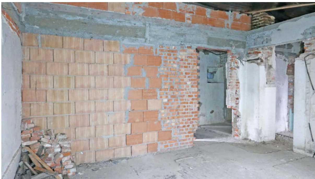
Fot. nr 15. Kraków, Plac Kossaka 4, parter, pom. nr 1.1, ujęcie w kierunku południowym, widoczna ściana północnej przybudówki niemal w całości współcześnie wymurowana z pustaków oraz cegły maszynowej, kładzionych na zaprawie cementowo - wapiennej, górą widoczny współcześnie wprowadzony wieniec żelbetowy, powstały w czasie ostatniej akcji budowlanej. Fot. M.J.Łukacz 2020 r.
