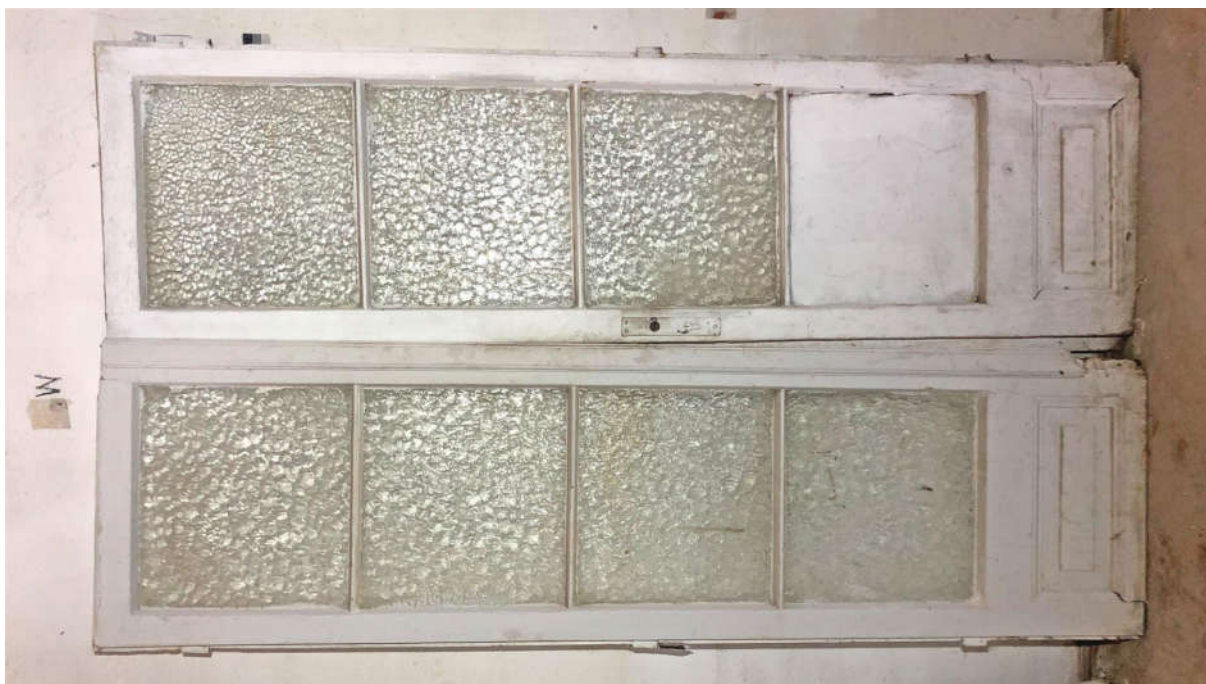
Fot. nr 71, 72. Kraków, Plac Kossaka 4, parter, pom. nr 2.1, widoczna zdemontowana stolarka drzwi dwuskrzydłowych, przeszklonych ośmiopolowych z wąskimi dolnymi płycinami o prostokątnym wypełnieniu, z nadświetłem ościeżnicy, prowadząca na werandę w elewacji południowej (nr el. zab I - D8) Fot. M.J.Łukacz 2020 r.
