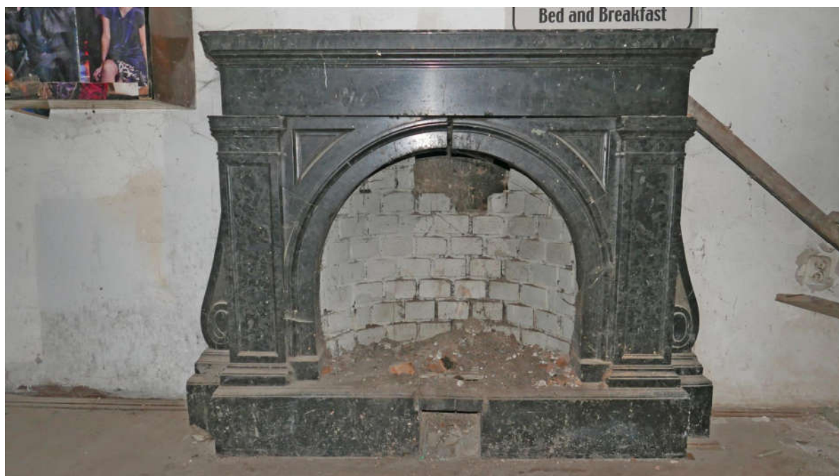
Fot. nr 47. Kraków, Plac Kossaka 4, parter, pom. nr 2.1, widoczny kominek wykonany z czarnego marmuru z paleniskiem w kształcie konchy, flankowany parą lizen, zwieńczony belkowaniem (nr el. zab. IV-K) Fot. M.J.Łukacz 2020 r.
