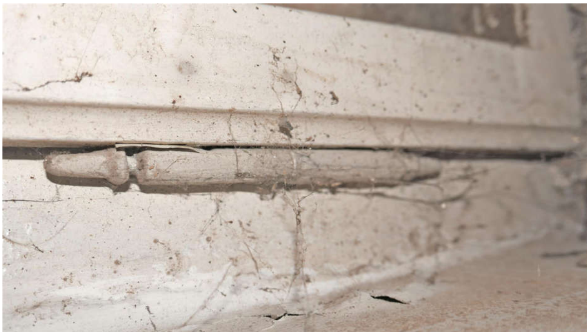
Fot. nr 29, 30. Kraków, Plac Kossaka 4, parter, pom. nr 1.2, widoczne zachowane zawiasy typu francuskiego oraz mosiężne klameczkami stolarki drzwiowej (nr el. zab. I-O2) Fot. M.J. Łukacz 2020 r.
