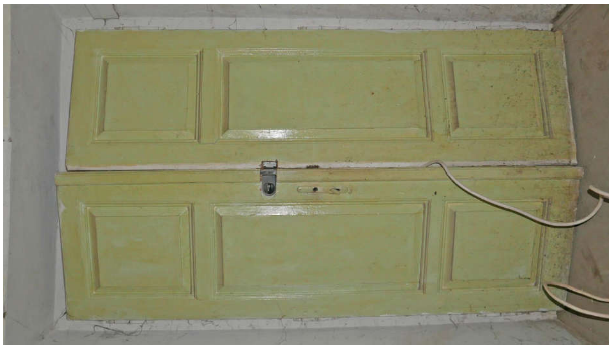
Fot. nr 21, 22. Kraków, Plac Kossaka 4, parter, pom. nr 2.1, widoczna stolarka drzwi dwuskrzydłowych, płycinowa, sześciopolowa z listą przymykową oraz z zachowanymi zawiasami typu francuskiego, od strony zewnętrznej wtórnie obita wygłuszeniem (nr el. zab. I – D3) Fot. M.J.Łukacz 2020 r.
