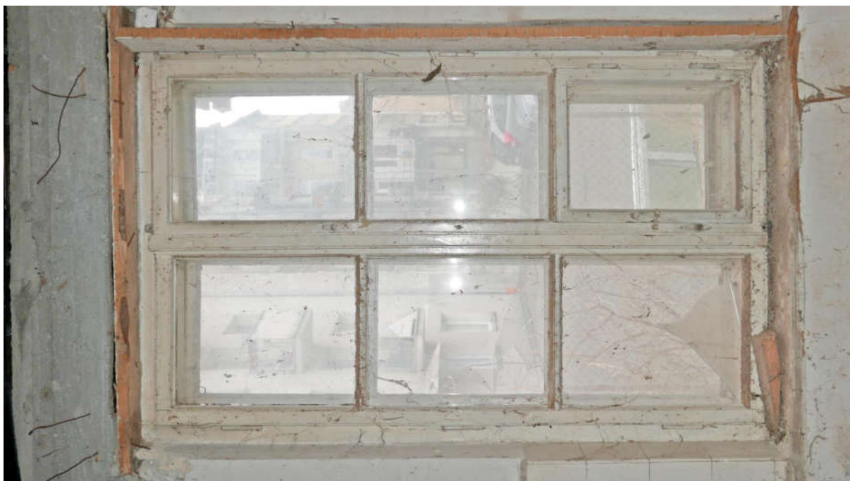
Fot. nr 26. Kraków, Plac Kossaka 4, parter, pom. nr 1.3, widoczna stolarka okna o konstrukcji skrzynkowej, dwuskrzydłowej, sześciopolowej o dodatkowo otwieranej dolnej kwaterze skrzydła prawego, z zachowanymi klameczkami oraz szplintami (nr el. zab. I – O1) Fot. M.J.Łukacz 2020 r.
