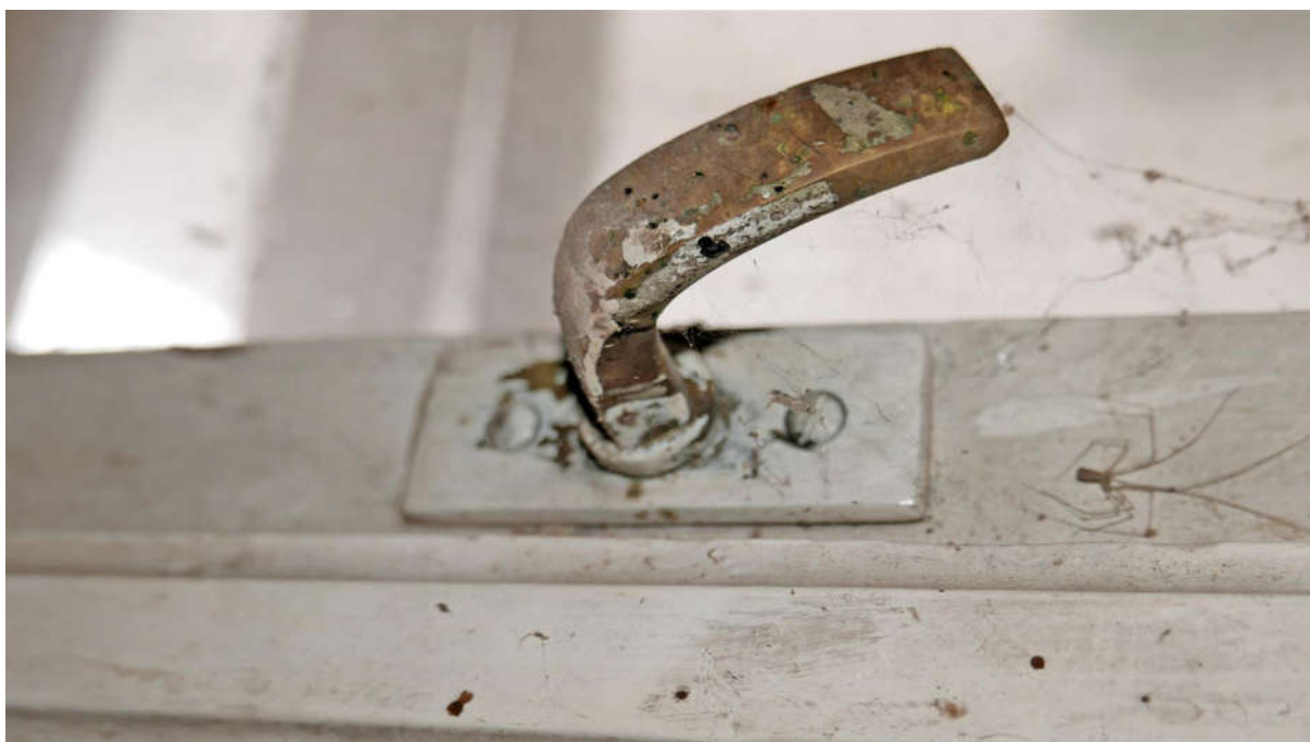
Fot. nr 29, 30. Kraków, Plac Kossaka 4, parter, pom. nr 1.2, widoczne zachowane zawiasy typu francuskiego oraz mosiężne klameczkami stolarki drzwiowej (nr el. zab. I-O2) Fot. M.J. Łukacz 2020 r.
