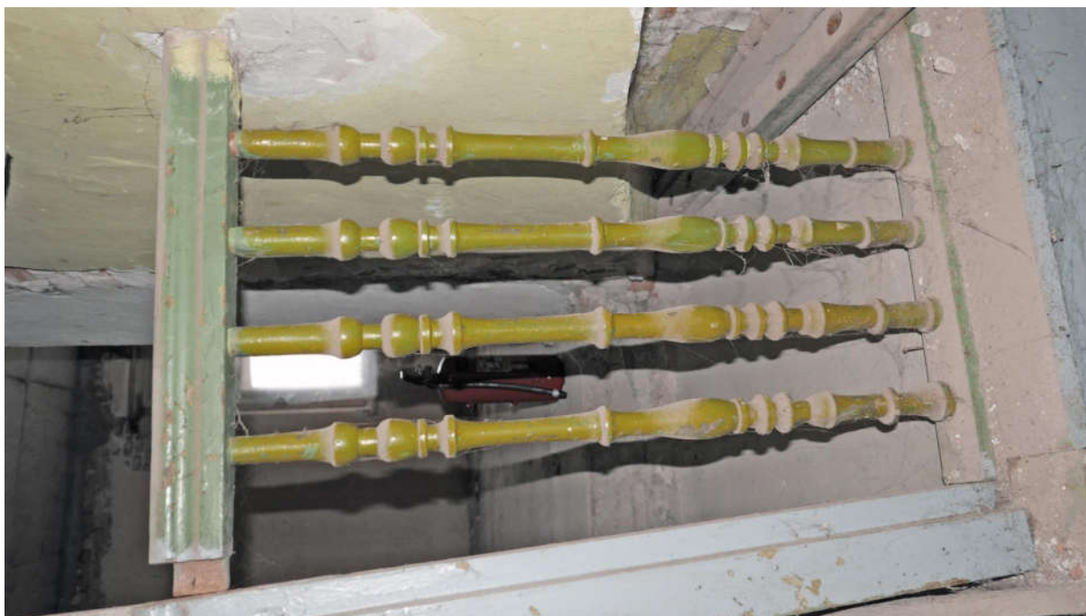
Fot. nr 51. Kraków, Plac Kossaka 4, widoczny zachowany fragment balustrady w poziomie użytkowym poddasza, złożonej z czterech smukłych, jednolalkowych tralek oraz profilowanego pochwyty (nr el. zab. I-BA) Fot. M.J.Łukacz 2020 r.
