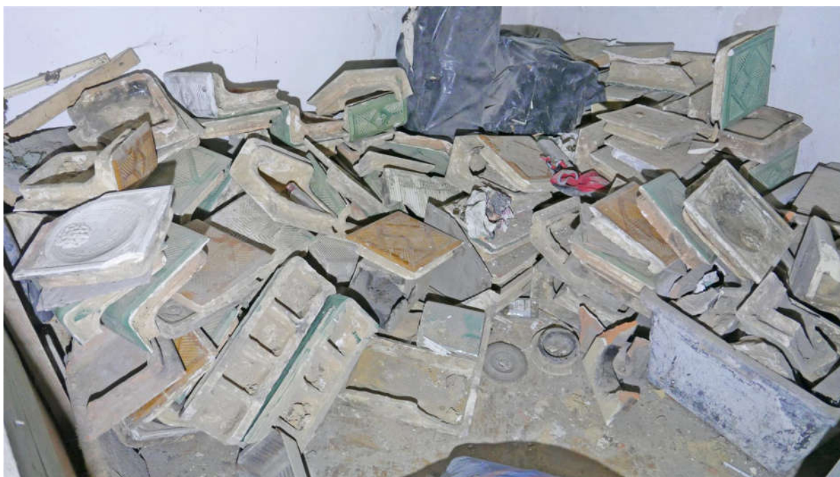
Fot. nr 55, 56. Kraków, Plac Kossaka 4, parter, pom. nr 2.2, widoczne luźno złożone i niewłaściwie składowane kafle niefachowo rozebranych piecy. Rozmaitość form oraz kolorów kafli a także czytelne odmienne rodzaje ich dekoracji świadczą o pochodzeniu z co najmniej czterech pieców, należących do zabytkowego wyposażenia budynku (nr el. zab. II-1) Fot. M.J.Łukacz 2020 r.
