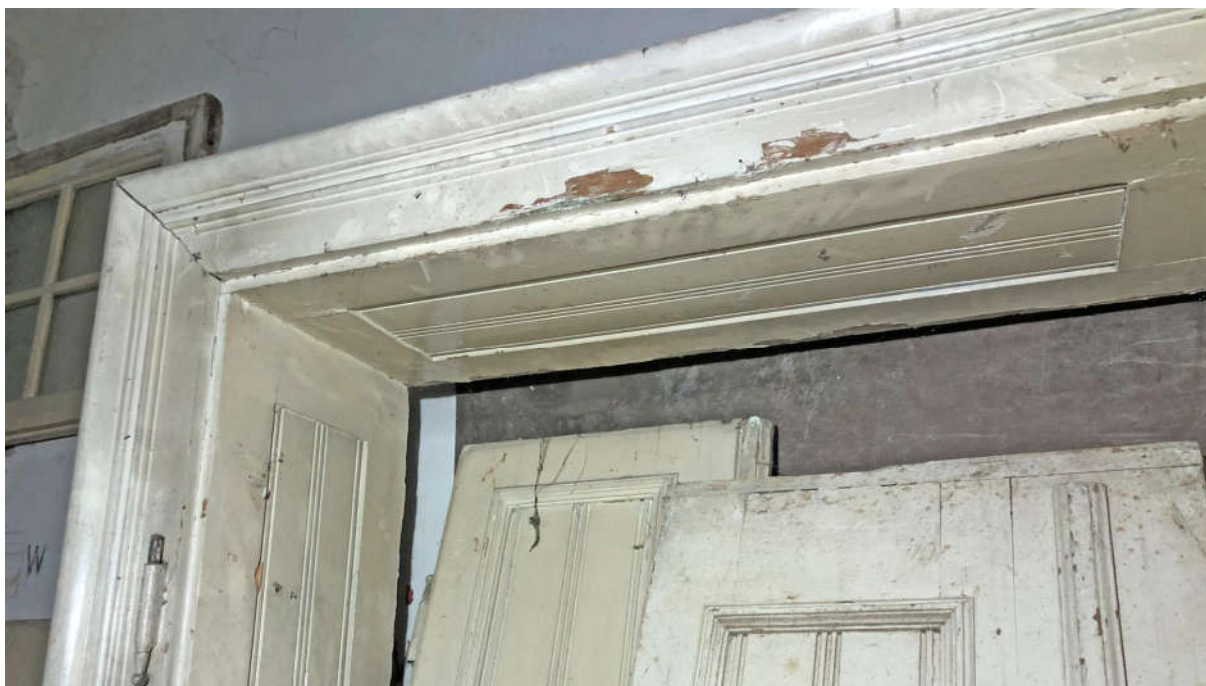
Fot. nr 61, 62. Kraków, Plac Kossaka 4, parter, pom. nr 2.1, widoczny zdemontowany zestaw stolarki drzwiowej, dwuskrzydłowej o konstrukcji płycinowej, sześciopolowej wraz z trójpółową płycinową ościeżnicą z profilowanym obramieniem (o podziale pól nawiązującym do układu profili podziałów drewnianej boazerii, por. fot, nr 52) z zachowanymi zawiasami typu francuskiego (nr el. zab. I – D5) Fot. M.J.Łukacz 2020 r.
