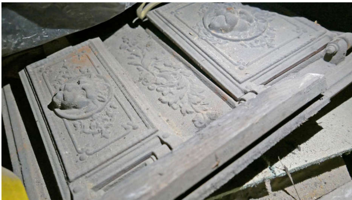
Fot. nr 57. Kraków, Plac Kossaka 4, parter, pom. nr 2.1, widoczne zdemontowane żeliwne drzwiczki zestawu paleniska i wyczystki o dekoracji roślinnej oraz z motywem lwich głów, rozebranego pieca, składowane wraz z kaflami w drewnianej skrzyni (nr el. zab. II-1) Fot. M.J.Łukacz 2020 r.
