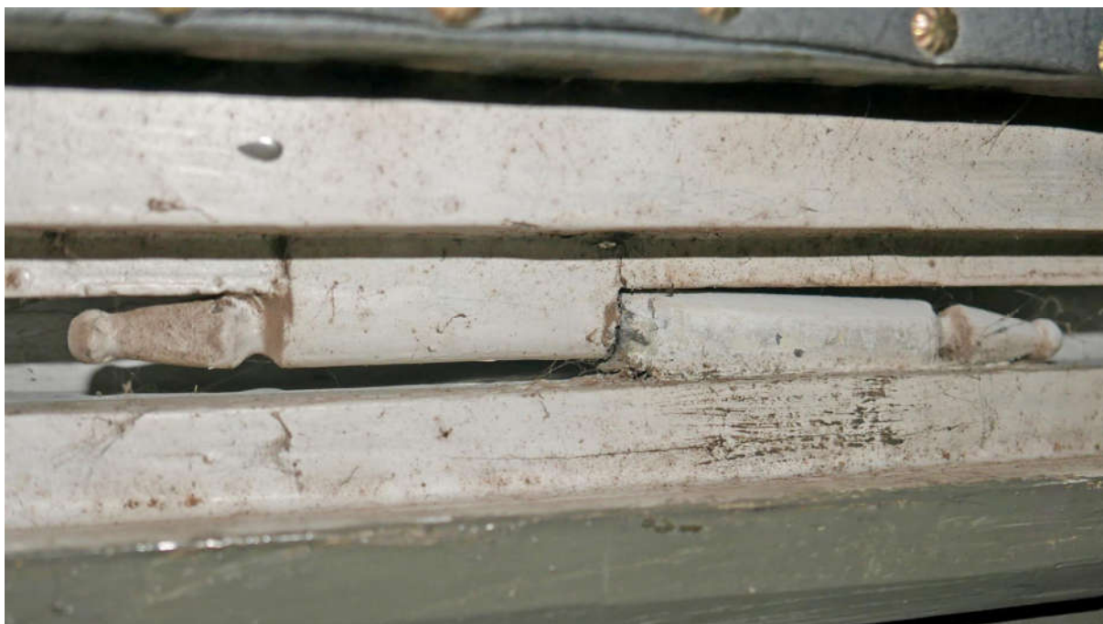
Fot. nr 21, 22. Kraków, Plac Kossaka 4, parter, pom. nr 2.1, widoczna stolarka drzwi dwuskrzydłowych, płycinowa, sześciopolowa z listą przymykową oraz z zachowanymi zawiasami typu francuskiego, od strony zewnętrznej wtórnie obita wygłuszeniem (nr el. zab. I – D3) Fot. M.J.Łukacz 2020 r.
