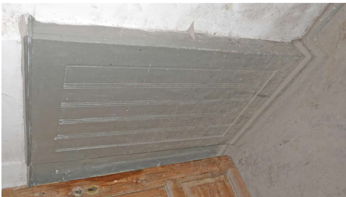
Fot. nr 52. Kraków, Plac Kossaka 4, parter, pom. nr W0.4, widoczny fragment zachowanej drewnianej boazerii, obramionej profilowanymi listwami oraz o dekoracji lica w postaci pionowych pól analogicznych do podziałów profilowań płycin ościeżnicy zdemontowanej stolarki drzwiowej (nr el. zab. I-BO), por. fot. nr 61, 62. Fot. M.J.Łukacz 2020 r.
