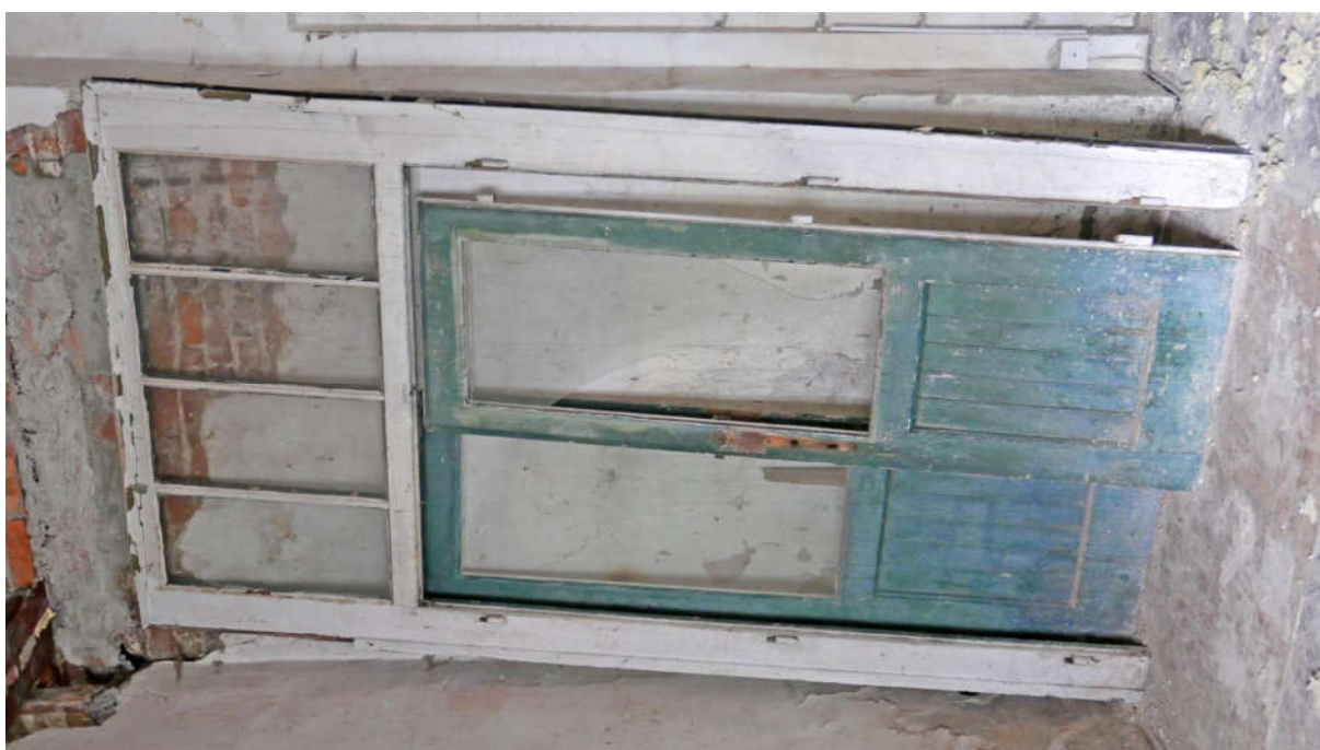
Fot. nr 64. Kraków, Plac Kossaka 4, parter, pom. nr 1.2, widoczny zestaw zdemontowanej stolarki wraz z ościeżnicą o konstrukcji płycinowej, dwuskrzydłowej, czteropolowej o górnych polach przeszklonych wraz z czteropolowym przeszklonym nadświetłem z częściowo zachowanym szkleniem kwater (nr el. zab. I – D6) Fot. M.J.Łukacz 2020 r.
