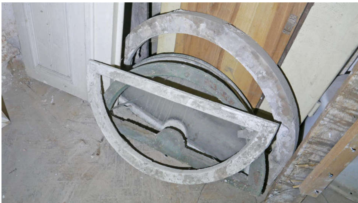
Fot. nr 63. Kraków, Plac Kossaka 4, parter, pom. nr 2.1, widoczne zdemontowane półkoliście zamknięte górne partie stolarki okulusa (nr el. zab. I – O9) Fot. M.J.Łukacz 2020 r.
