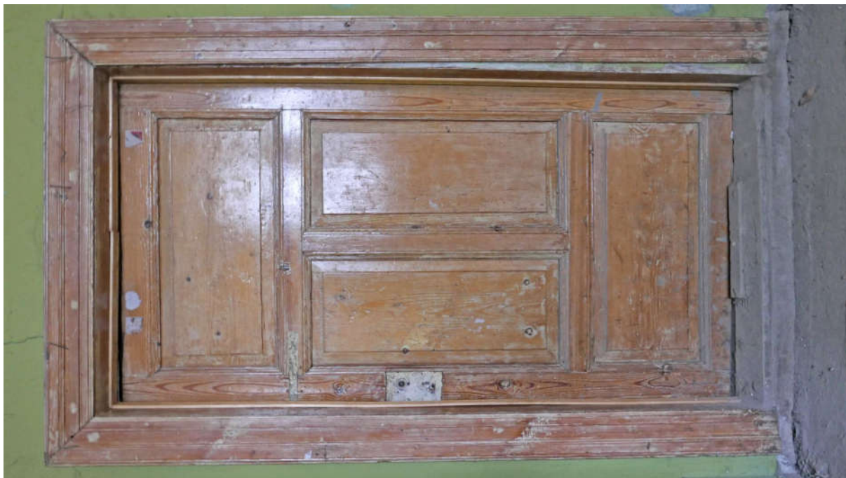
Fot. nr 23, 24. Kraków, Plac Kossaka 4, parter, pom. nr 2.2, widoczna stolarka drzwi jedno-skrzydłowych, płycinowa, czteropolowa z profilowanym obramieniem ościeżnicy oraz z zachowanymi zawiasami typu francuskiego wraz z zestawem tworzącym szyld z zamkiem oraz mosiężną klamką (nr el. zab. I – D4) Fot. M.J.Łukacz 2020 r.
