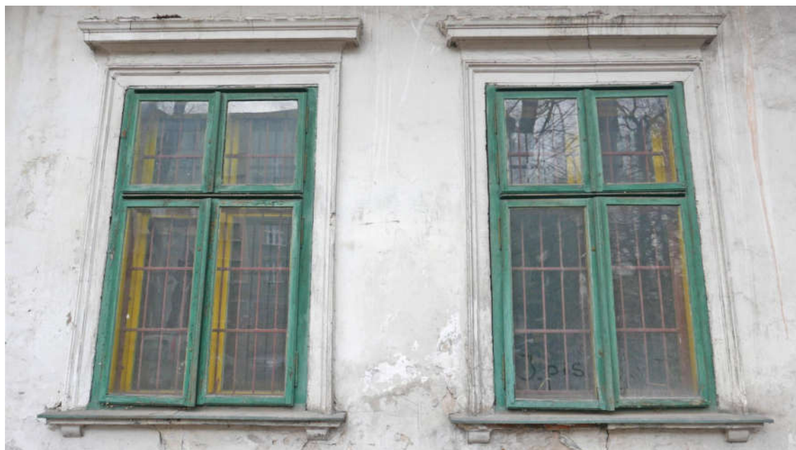
Fot. nr 8. Kraków, Plac Kossaka 4 , elewacja południowa, partia wschodnia, widoczna stolarka okien o konstrukcji skrzynkowej, czteropolowych, czteroskrzydłowych z podziałem proporcji szklenia 1/3 - 2/3 z zachowanymi zawiasami typu francuskiego oraz klamczkami skrzydeł ( nr el. zab. O - 3 ) Fot. M.J.Łukacz 2020 r.
