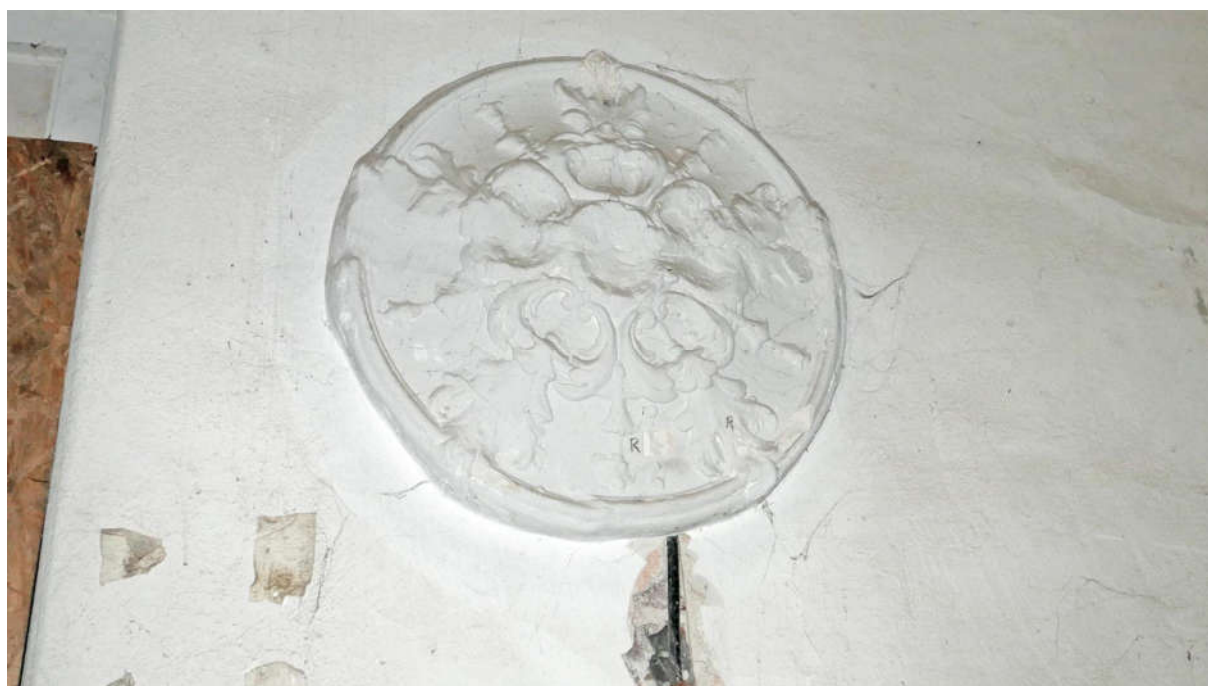
Fot. nr 48. Kraków, Plac Kossaka 4, parter, pom. nr 2.1, widoczna rozeta sufitowa o mocno wyobłonej formie zdobień stylizowanych na kształty roślinne, zamocowana wtórnie na ścianie południowej (nr el. zab. V-2) Fot. M.J.Łukacz 2020 r.
