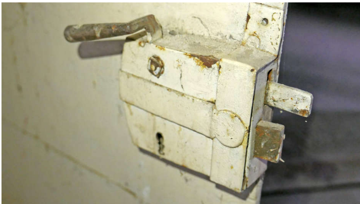
Fot. nr 53, 54. Kraków, Plac Kossaka 4, poddasze, pom. nr 1.8, widoczna ślusarka drzwi z zachowanym zamkiem puszkowym oraz rozetką w formie nawiązującej do dekoracji roślinnej, osadzonej na skrzyżowaniu płaskowników blachy (nr el. zab. III-1) Fot. M.J.Łukacz 2020 r.
