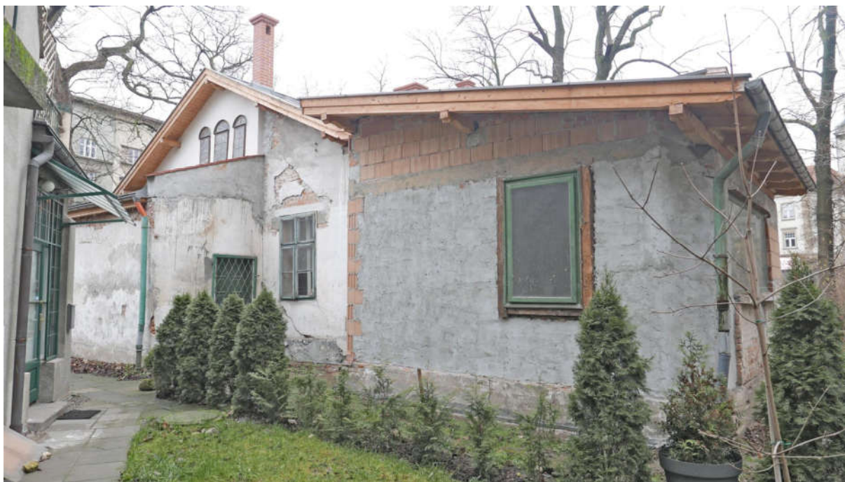
Fot. nr 5. Kraków, Plac Kossaka 4, elewacja wschodnia parterowej przybudówki północnej, pozbawiona wystroju architektonicznego, widok ogólny, stan obecny. Fot. M.J.Łukacz 2020 r.
