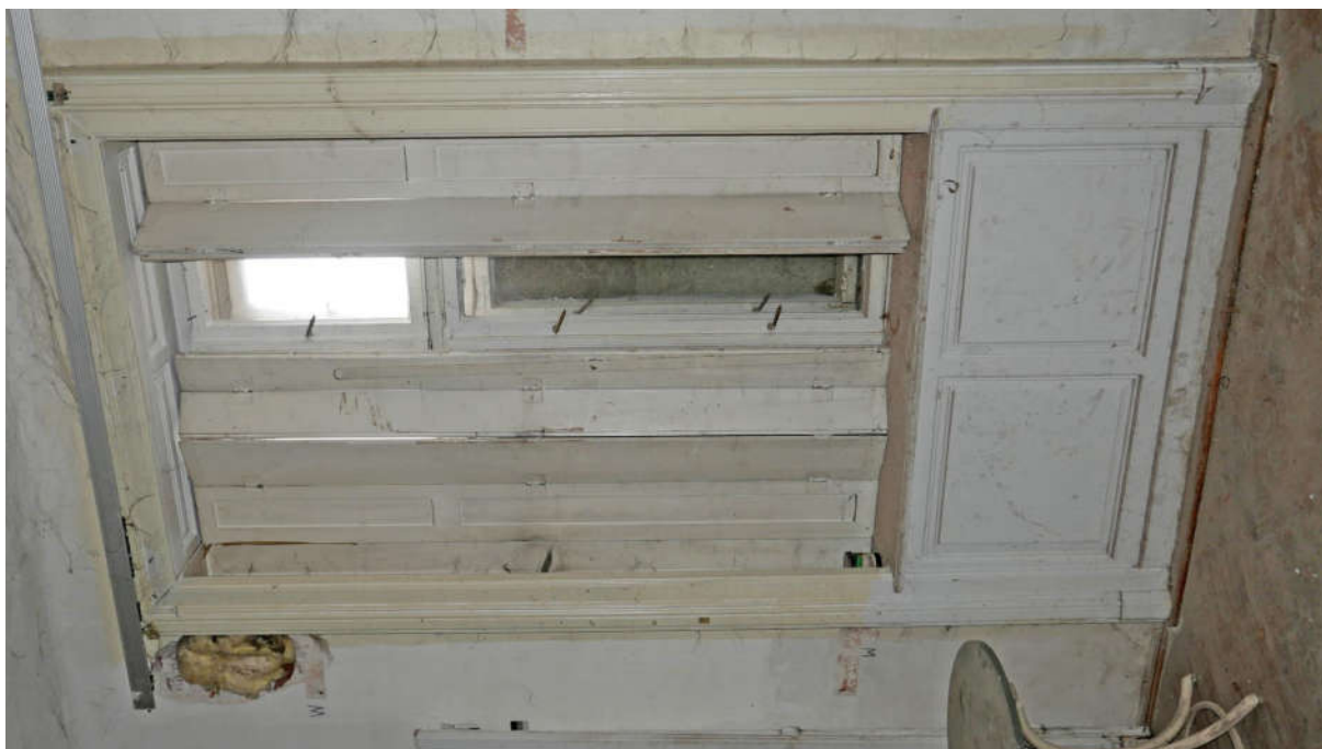
Fot. nr 37, 38. Kraków, Plac Kossaka 4, parter, pom. nr 2.1, widoczna stolarka okna o konstrukcji skrzynkowej, czteroskrzydłowej, czteropolowej z profilowanymi, trójpółowymi, składanymi szpaletami, z zachowanymi zawiasami typu francuskiego oraz klameczkami i szplintami skrzydeł a także z obramieniem sięgającym poziomu parkietu wraz z profilowanym, płycinowym, dwupółowym wypełnieniem partii podparapetowej (nr el. zab. I-O5) Fot. M.J.Łukacz 2020 r.
