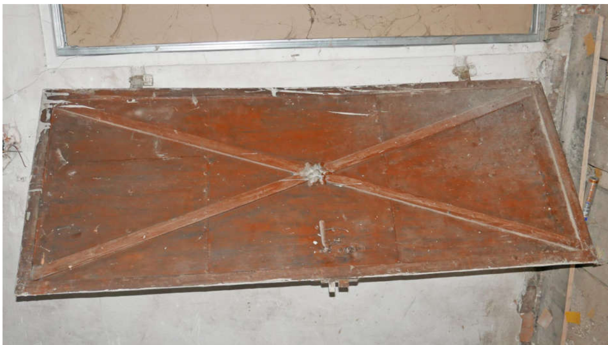
Fot. nr 53, 54. Kraków, Plac Kossaka 4, poddasze, pom. nr 1.8, widoczna ślusarka drzwi z zachowanym zamkiem puszkowym oraz rozetką w formie nawiązującej do dekoracji roślinnej, osadzonej na skrzyżowaniu płaskowników blachy (nr el. zab. III-1) Fot. M.J.Łukacz 2020 r.
