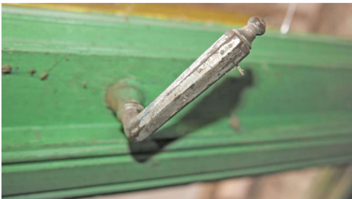
Fot. nr 31, 32. Kraków, Plac Kossaka 4, parter, pom. nr LU.1.1, widoczna stolarka okna o konstrukcji skrzynkowej, czteroskrzydłowej, czteropolowej z zachowanymi zawiasami typu francuskiego oraz mosiężnymi klameczkami. W ościeżach okna widoczne wnęki wykonane w tynku dla niezachowanych szpalet dolnych skrzydeł (nr el. zab. I-O3) Fot. M.J.Łukacz 2020 r.
