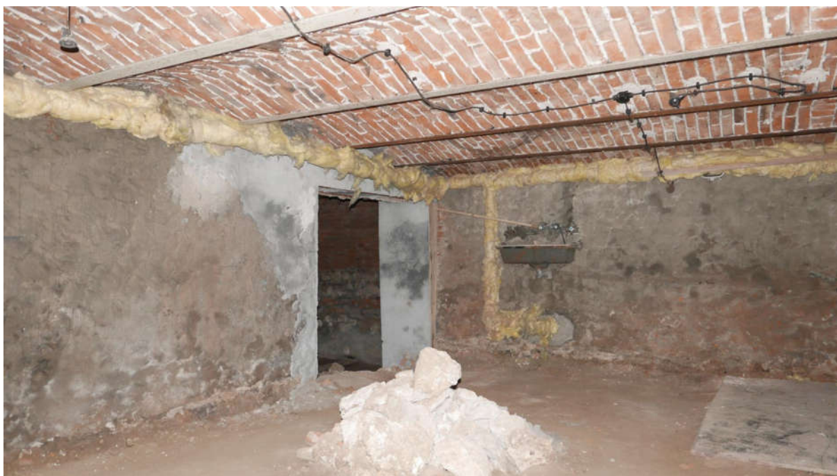
Fot. nr 75, 76. Kraków, Plac Kossaka 4, piwnice, widoczny stan obecny głównej komory piwnicznej, tynki ścian zasolone, zawilgocone oraz zagrzybione, górą ceramiczne sklepienie Klein'a. Fot. M.J.Łukacz 2020 r.
