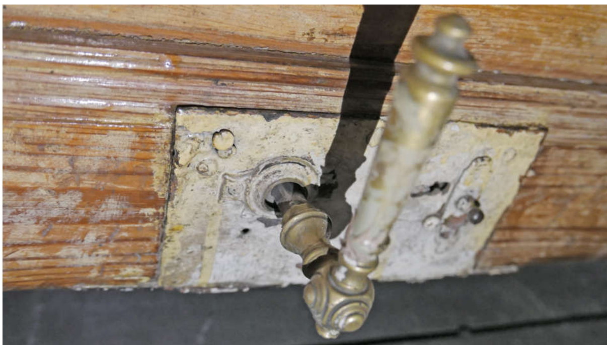
Fot. nr 23, 24. Kraków, Plac Kossaka 4, parter, pom. nr 2.2, widoczna stolarka drzwi jedno-skrzydłowych, płycinowa, czteropolowa z profilowanym obramieniem ościeżnicy oraz z zachowanymi zawiasami typu francuskiego wraz z zestawem tworzącym szyld z zamkiem oraz mosiężną klamką (nr el. zab. I – D4) Fot. M.J.Łukacz 2020 r.
