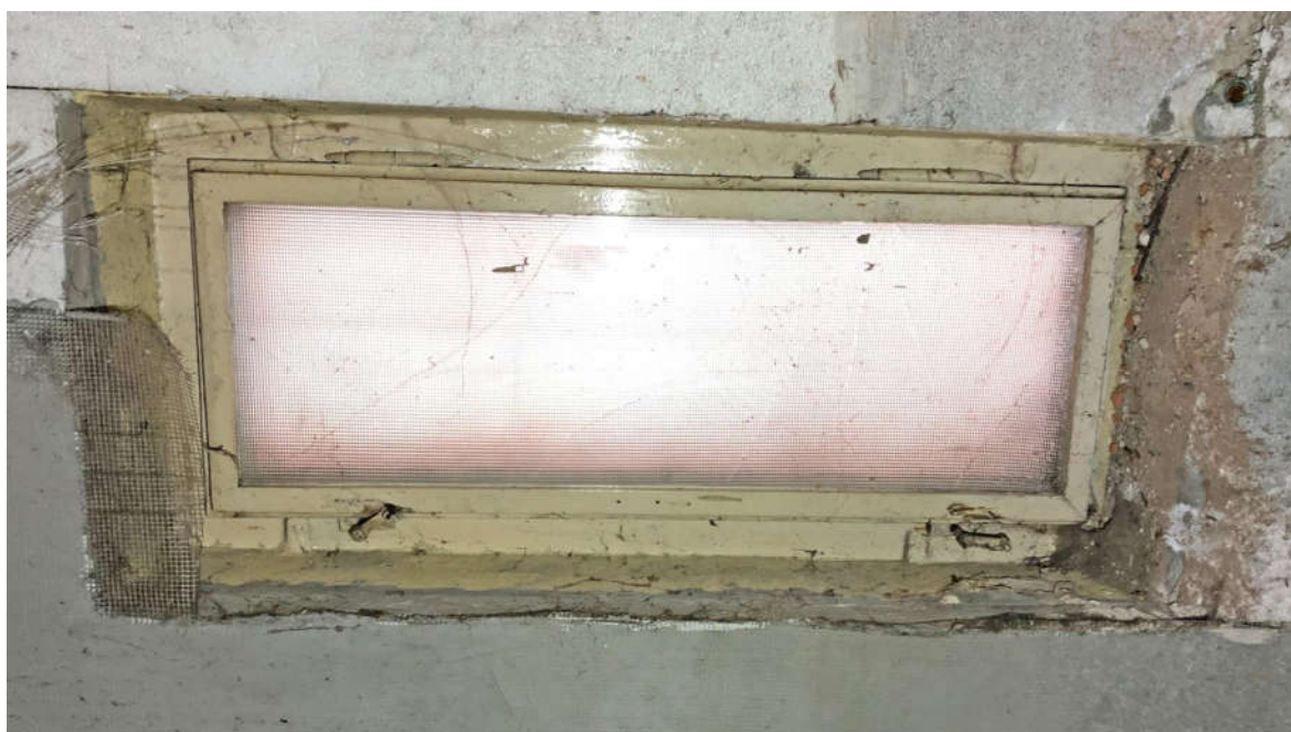
Fot. nr 46. Kraków, Plac Kossaka 4, parter, pom. nr 2.6, stolarka jednoskrzydłowego, jed-nopolowego wąskiego okienka z zachowanymi zawiasami typu francuskiego oraz z zawrotnicami (nr el. zab. I-O10) Fot. M.J.Łukacz 2020 r.
