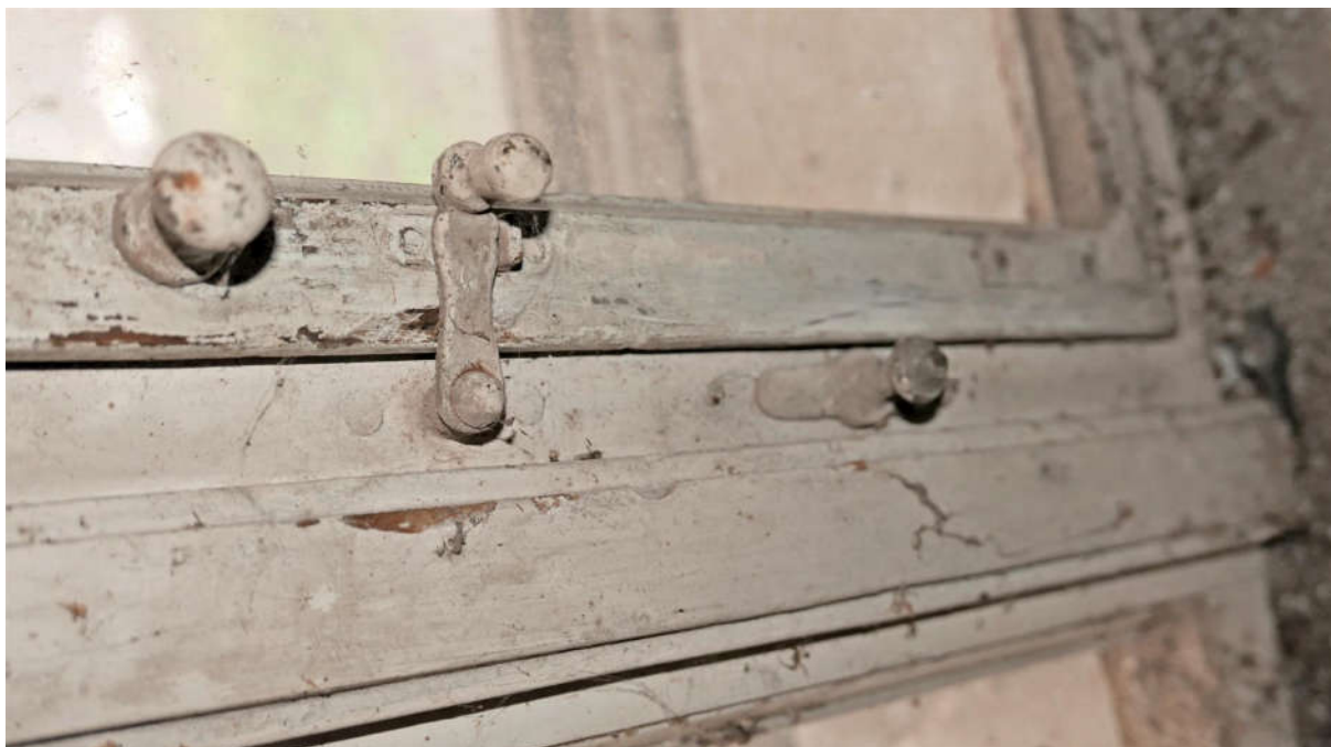
Fot. nr 27. Kraków, Plac Kossaka 4, parter, pom. nr 1.3, detal kwatery skrzydła okna o konstrukcji skrzynkowej, dwuskrzydłowej, sześciopolewej z zachowanymi klameczkami oraz szplintami (nr el. zab. I – O1) Fot. M.J.Łukacz 2020 r.
