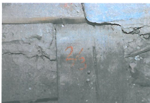
Fot. 13, 14 Belki w pomieszczeniu nr 2 – brak porażenia biologicznego.
