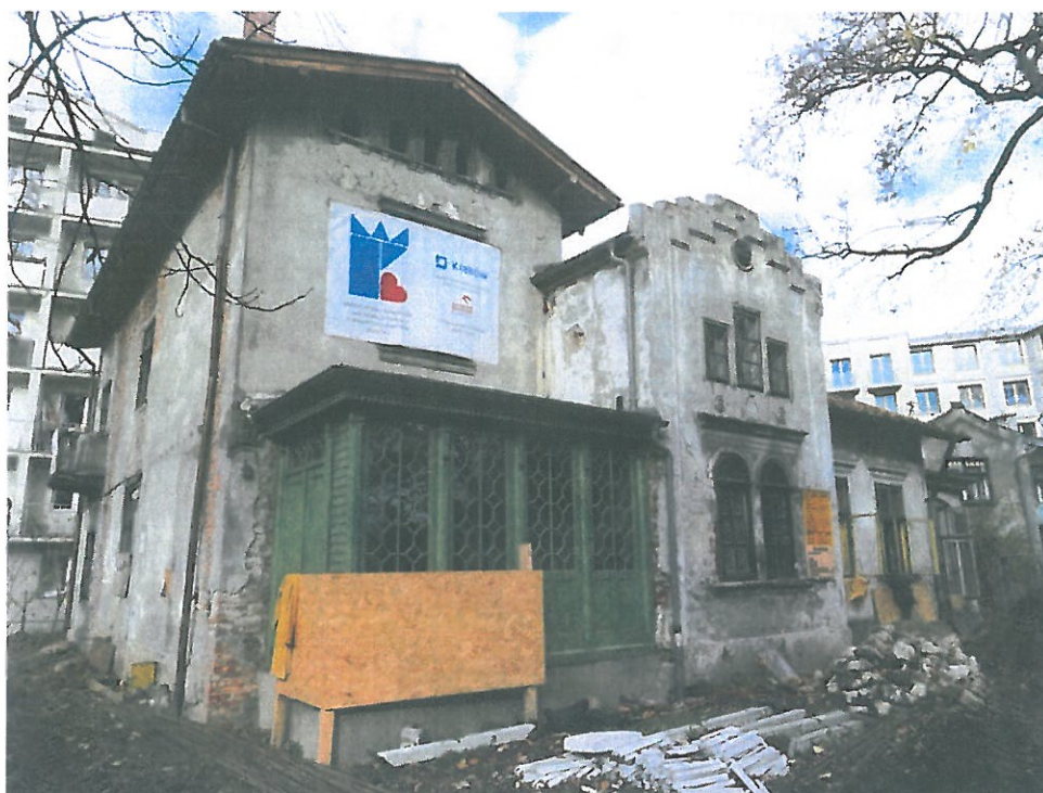
Fot. 1 Fasada południowa budynku: „Willi Kossakówka” od strony Placu Kossaka.
