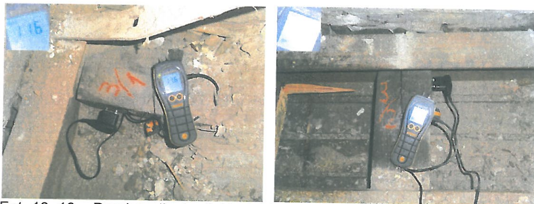
Fot. 18, 19 Pomiar wilgotności belek konstrukcyjnych, drewnianych. Wilgotność strukturalna drewna: 11,4-11,6% - drewno suche.
