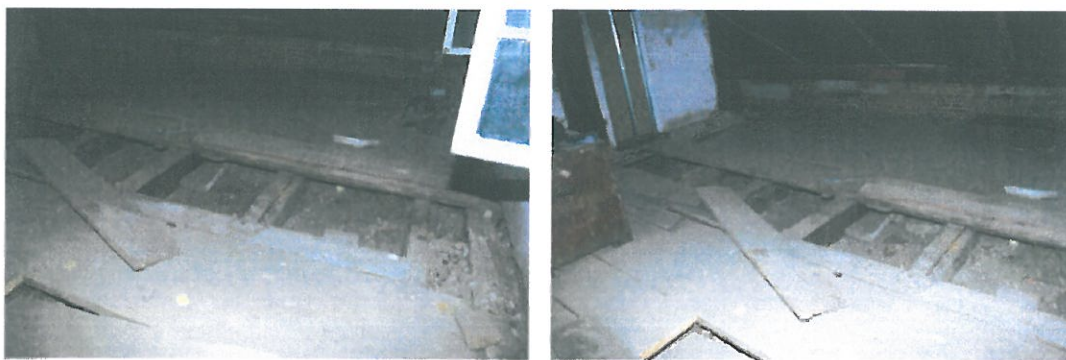
Fot. 3, 4 Miejsce odkrywki na łączeniu stropu drewnianego i żelbetowego.
