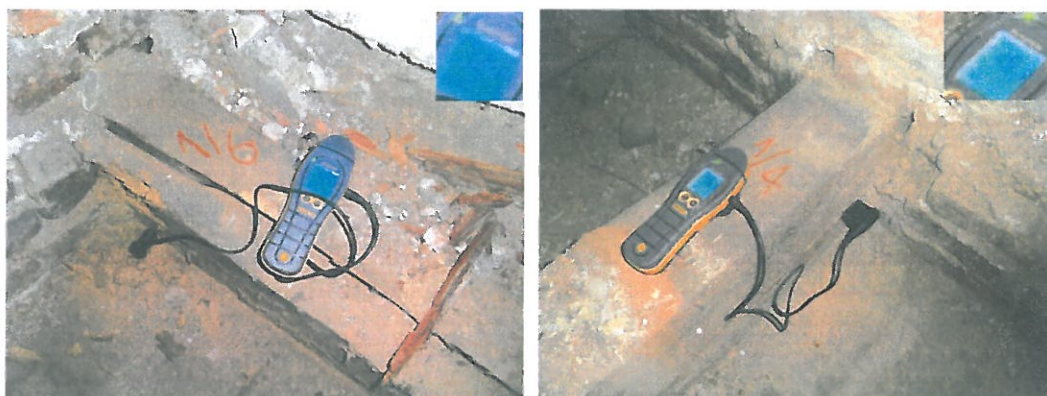
Fot. 8, 9 Pomiary wilgotności belek konstrukcyjnych w bezpośrednim sąsiedztwie muru. Wilgotność strukturalna drewna: 12,4-15,1% - drewno suche.
