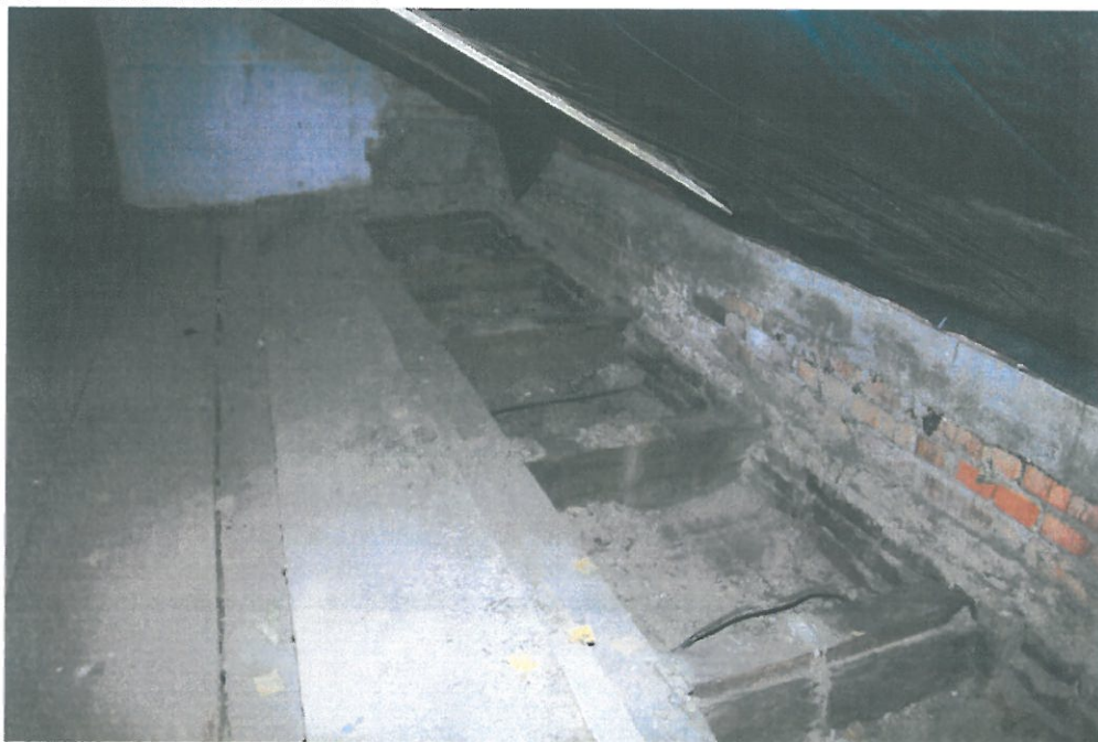
Fot. 2 Miejsce odkrywki belek konstrukcyjnych przy ścianie zewnętrznej.
