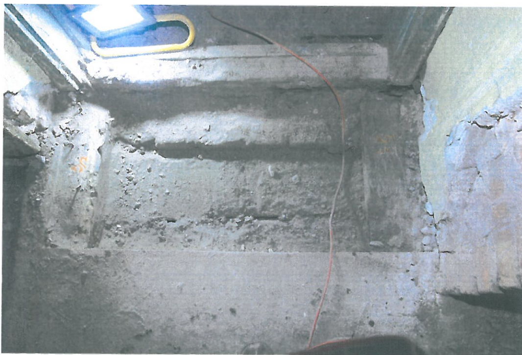
Fot. 23 Miejsce odkrytki – spocznik klatki schodowej
