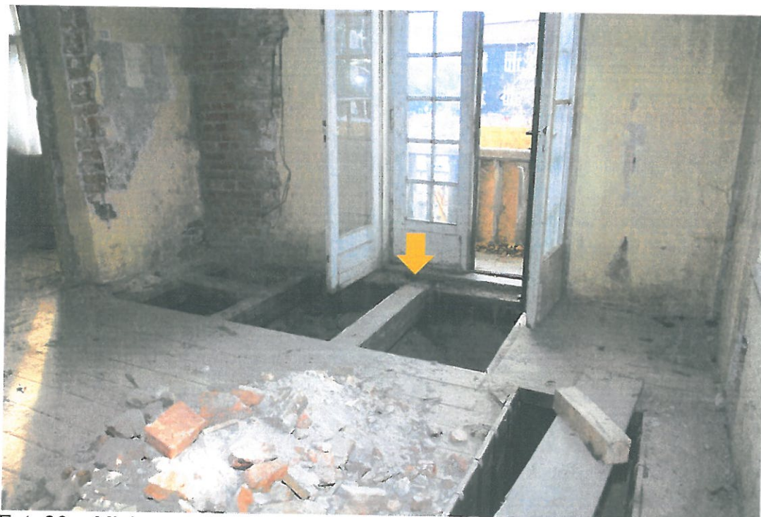
Fot. 20 Miejsce wykonania odkrywki.
