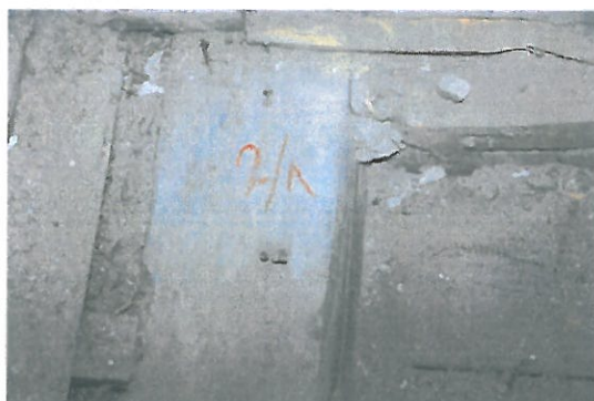
Fot. 13, 14 Belki w pomieszczeniu nr 2 – brak porażenia biologicznego.
