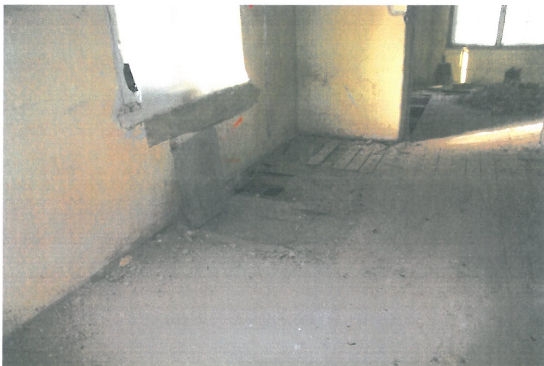
Fot. 15 Miejsce wykonania odkrywki.
