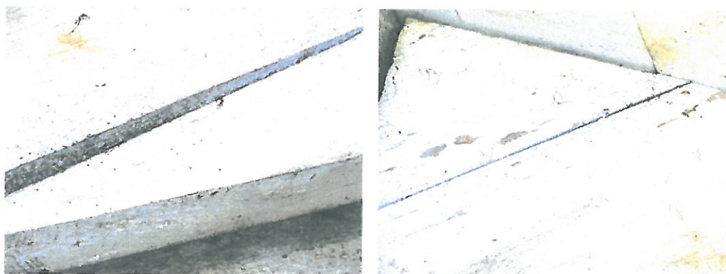
Fot. 5, 6 Zbliżenie belek spocznikowych zamocowanych do ściany liczne otwory wylotowe owadów – technicznych szkodników drewna.
