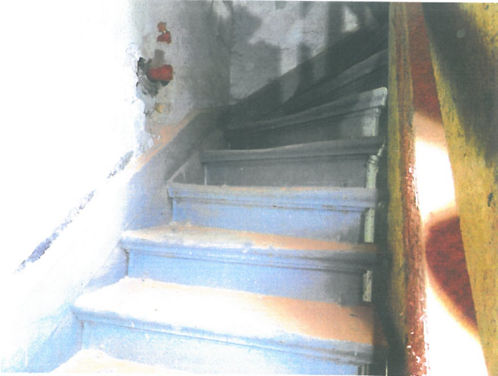
Fot. 2 Schody i opierzenie z desek pomalowane kilkoma warstwami farby olejnej częściowo łuszczącej się. Listwa cokołowa przyścienna zamocowana do belek spocznikowych. Od spodniej strony konstrukcja schodów pobiałkowana.
