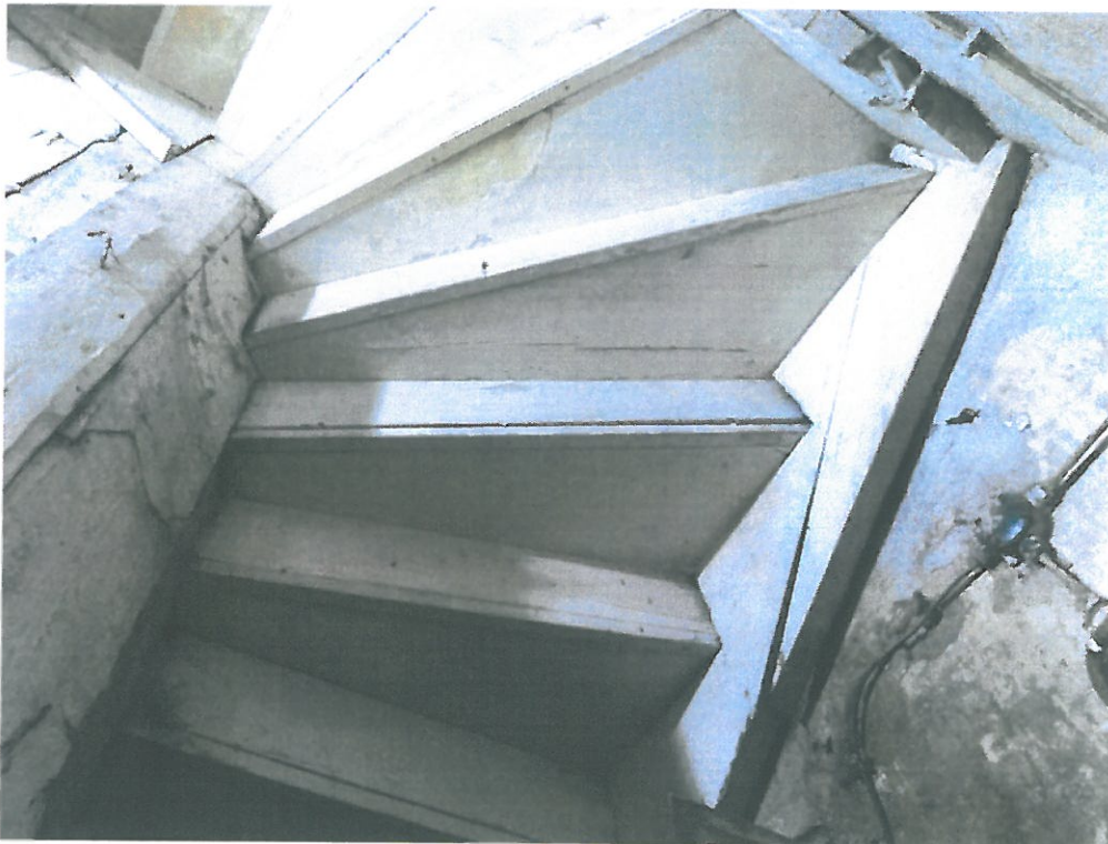
Fot. 2 Schody i opierzenie z desek pomalowane kilkoma warstwami farby olejnej częściowo łuszczącej się. Listwa cokołowa przyścienna zamocowana do belek spocznikowych. Od spodniej strony konstrukcja schodów pobiałkowana.
