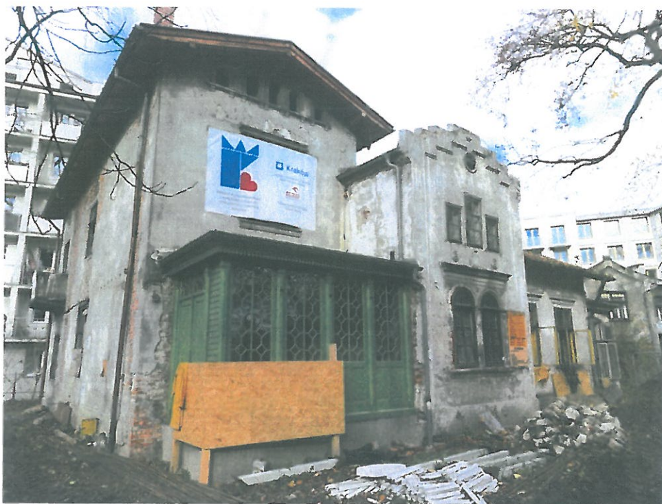
Fot. 1 Fasada południowa budynku od strony Placu Kossaka.
