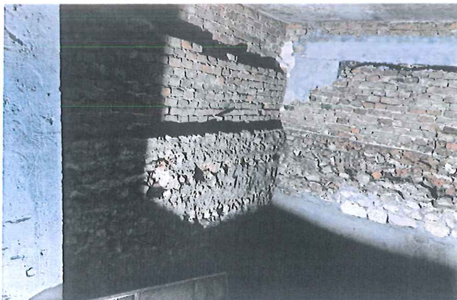
Fot. 1. Narożnik północno – wschodni pomieszczenia -1.04 w piwnicy budynku „Kossakówka”, Pl. Kossaka 4, Kraków. Widoczny pas gruzu i kamieni w dolnej części. Fot. Dorota Narowska Avonza, wrzesień 2021 r.
