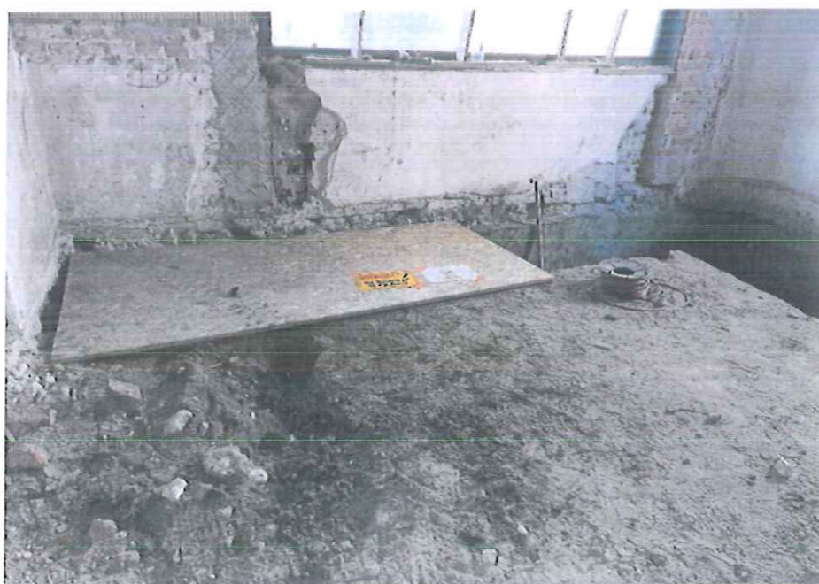
Fot. 6. Fundament odkopany w trakcie prac ziemnych, znajdujący się w pomieszczeniu 1.1 w budynku „Kossakówka”, Pl. Kossaka 4, Kraków. Fot. Dorota Narowska Avonza, wrzesień 2021 r.
