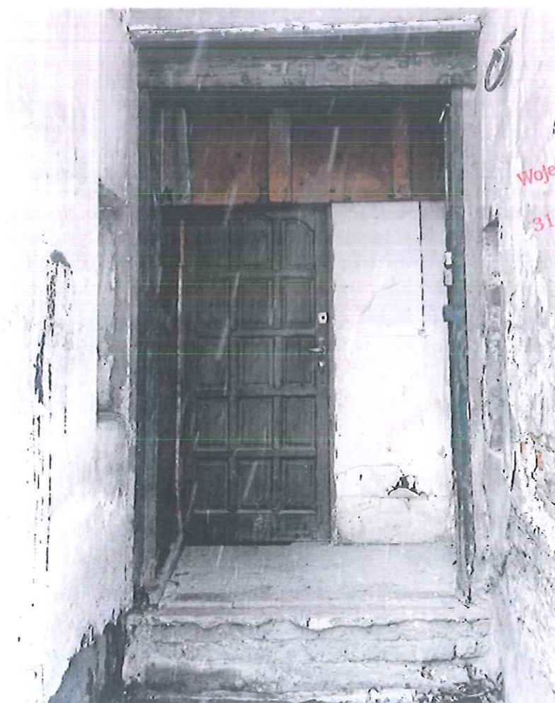
Fot. 8. Ścianka wtórna ze współczesną stolarką drzwiową, elewacja północna w budynku „Kossakówka”, Pl. Kossaka 4, Kraków. Fot. Dorota Narowska Avonza, wrzesień 2021 r.
