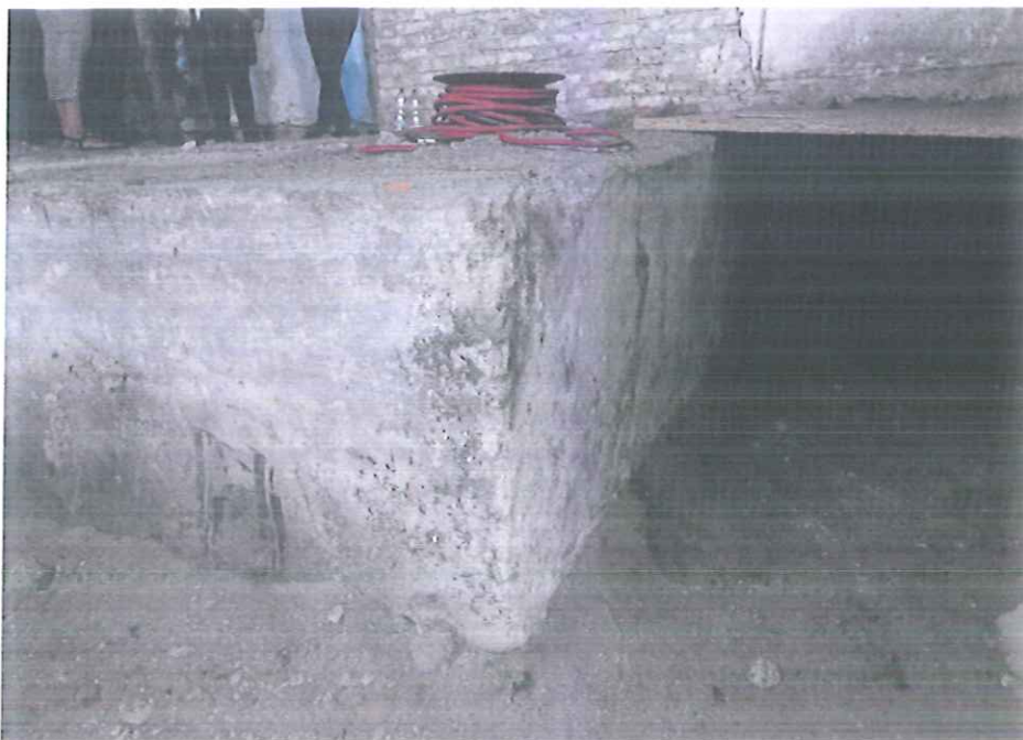
Fot. 7. Fundament odkopany w trakcie prac ziemnych, znajdujący się w pomieszczeniu 1.1 w budynku „Kossakówka”, Pl. Kossaka 4, Kraków. Fot. Dorota Narowska Avonza, wrzesień 2021 r.
