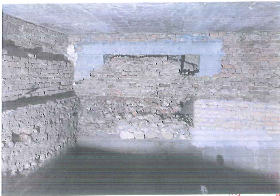
Fot. 2. Narożnik północno – wschodni pomieszczenia -1.04 w piwnicy budynku „Kossakówka”, Pl. Kossaka 4, Kraków. Widoczny pas gruzu i kamieni w dolnej części. Fot. Dorota Narowska Avonza, wrzesień 2021 r.
