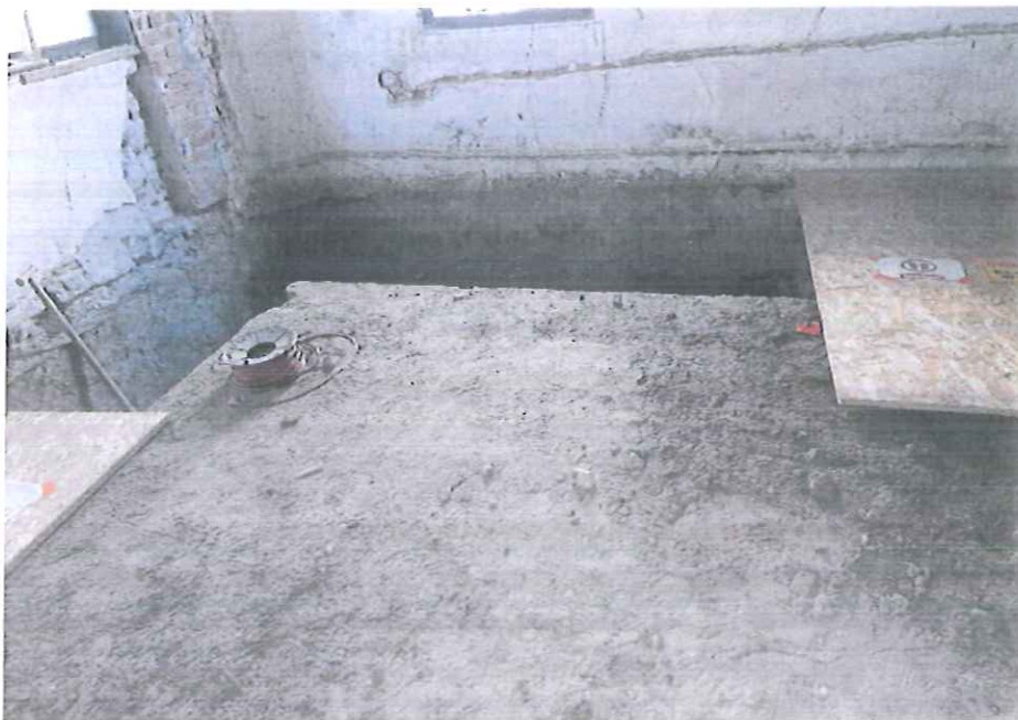
Fot. 5. Fundament odkopany w trakcie prac ziemnych, znajdujący się w pomieszczeniu 1.1 w budynku „Kossakówka”, Pl. Kossaka 4, Kraków. Fot. Dorota Narowska Avonza, wrzesień 2021 r.
